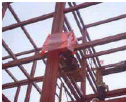
Figura 2.2 - Execução de solda protegida contra o vento. Fonte: USIMINAS, 2003.
