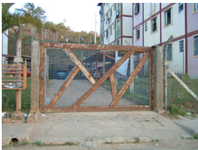
Figura 5.13 – Reutilização da estrutura metálica do contraventamento - portão.
