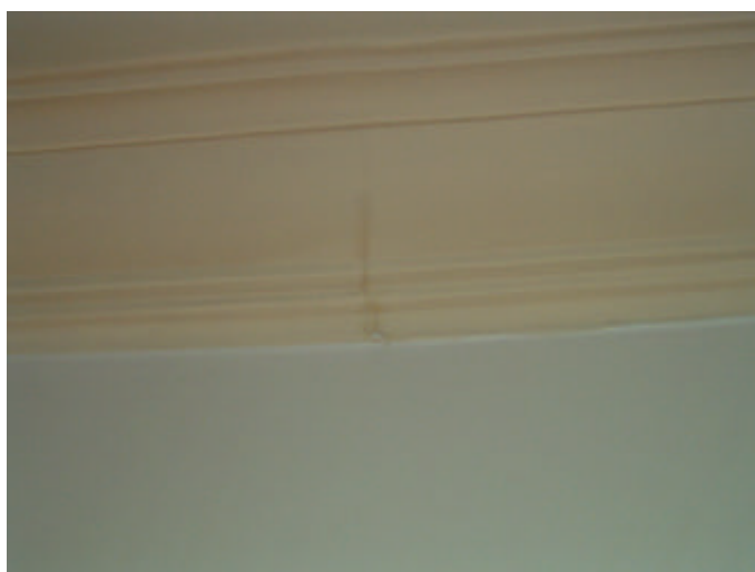
Figura 5.22 – Trincas em roda-teto.
