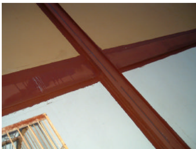
Figura 5.15 – Detalhe da pintura utilizada para melhorar a vedação entre estrutura e fechamento.
