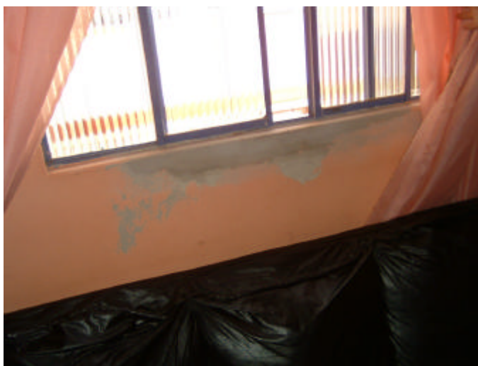
Figura 5.30 – Infiltração das águas das chuvas pelas aberturas.
