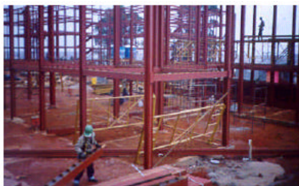
Figura 2.6 – Montagem das vigas.
