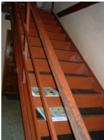
Figura 6.2 – Piso emborrachado colocado sobre a escada metálica.
