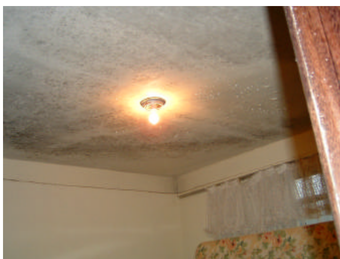
Figura 5.27 – Detalhe da laje de cobertura - infiltração.
