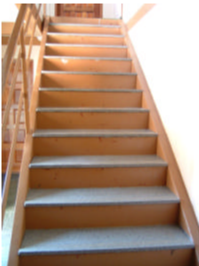
Figura 6.3 – Piso em granito colocado sobre a escada metálica.
