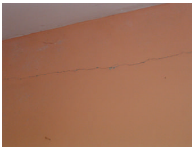
Figura 5.8 – Trinca entre a estrutura metálica e a alvenaria.
