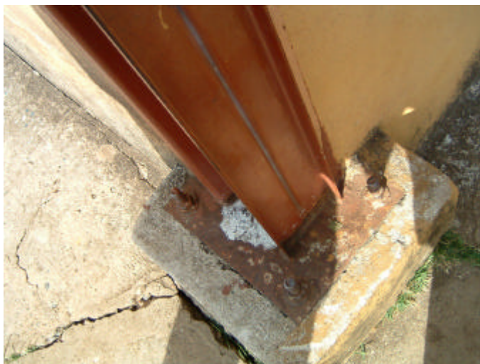
Figura 5.6 – Focos de corrosão na placa de base dos pilares.
