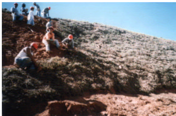
Figura 1.1 – Colocação de grama nos taludes. Fonte: MENDES, 1998.
