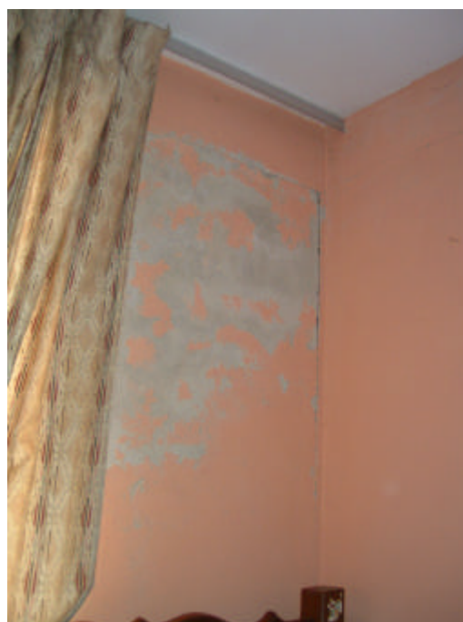
Figura 5.9 – Trincas entre o fechamento e a estrutura
