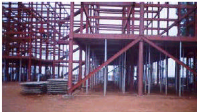
Figura 2.4 – Lajes escoradas prontas para a concretagem. Fonte: USIMINAS, 2003.
