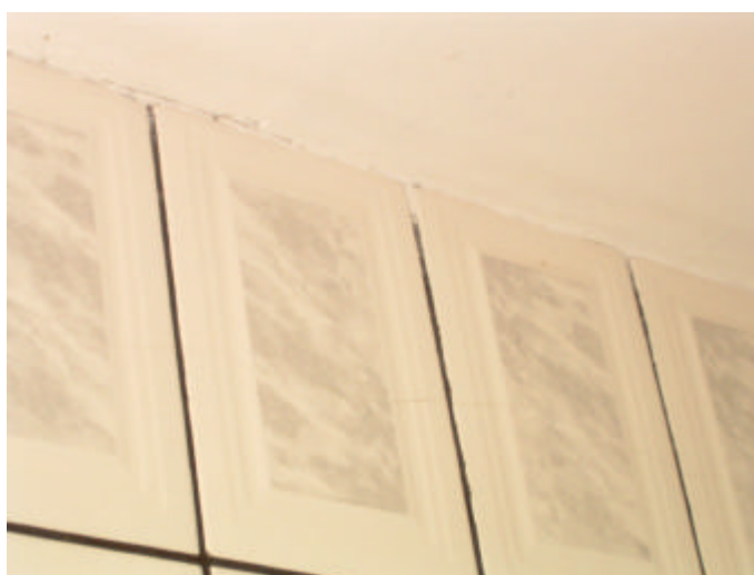
Figura 5.23 – Trincas em azulejos.
