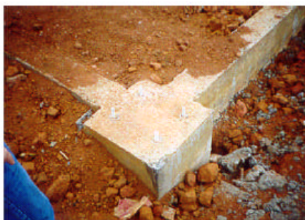
Figura 2.1 – Fundação superficial com chumbadores. Fonte: USIMINAS, 2003.
