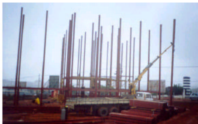
Figura 2.5 – Montagem das colunas utilizando guindaste. Fonte: USIMINAS, 2003.
