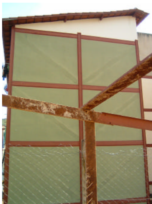
Figura 5.11 – Vista dos edifícios hoje, sem o contraventamento.
