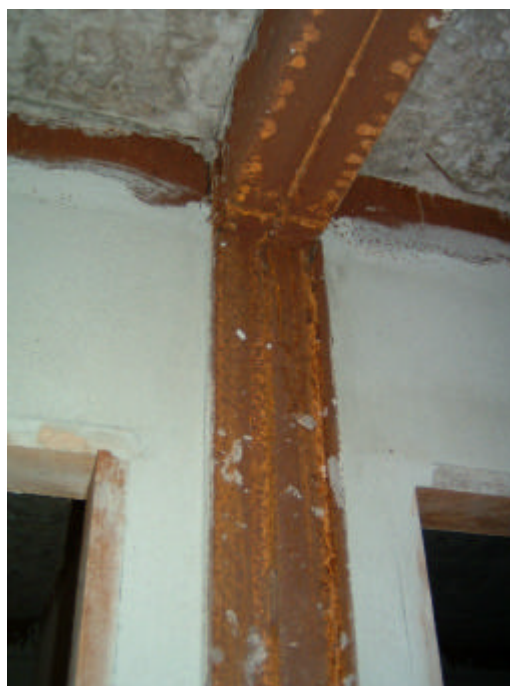
Figura 5.17 – Detalhe do aço patinável: apartamento sem acabamento.
