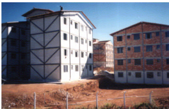
Figura 1.6 – Vespasiano – Estrutura metálica na cobertura. Fonte: MENDES, 1998.
