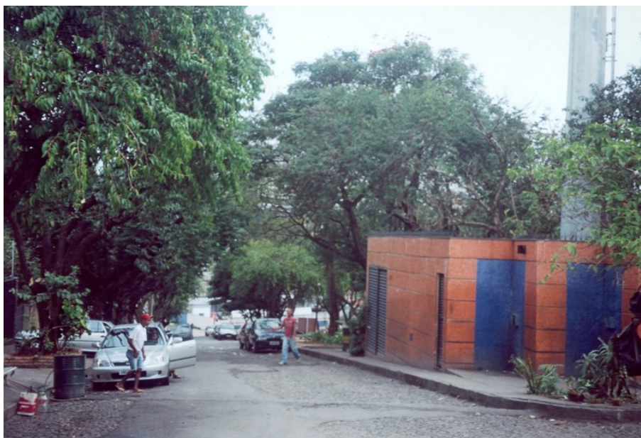
Figura 2.55 Torre de transmissão de telefonia Celular. Av. Bernardo Monteiro, BH.
