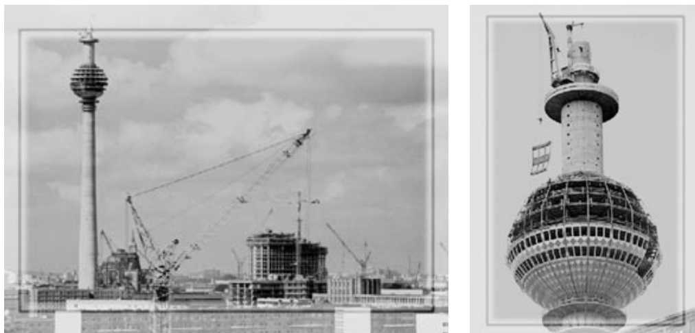
Figura 2.15 Construção da torre de Berlim
