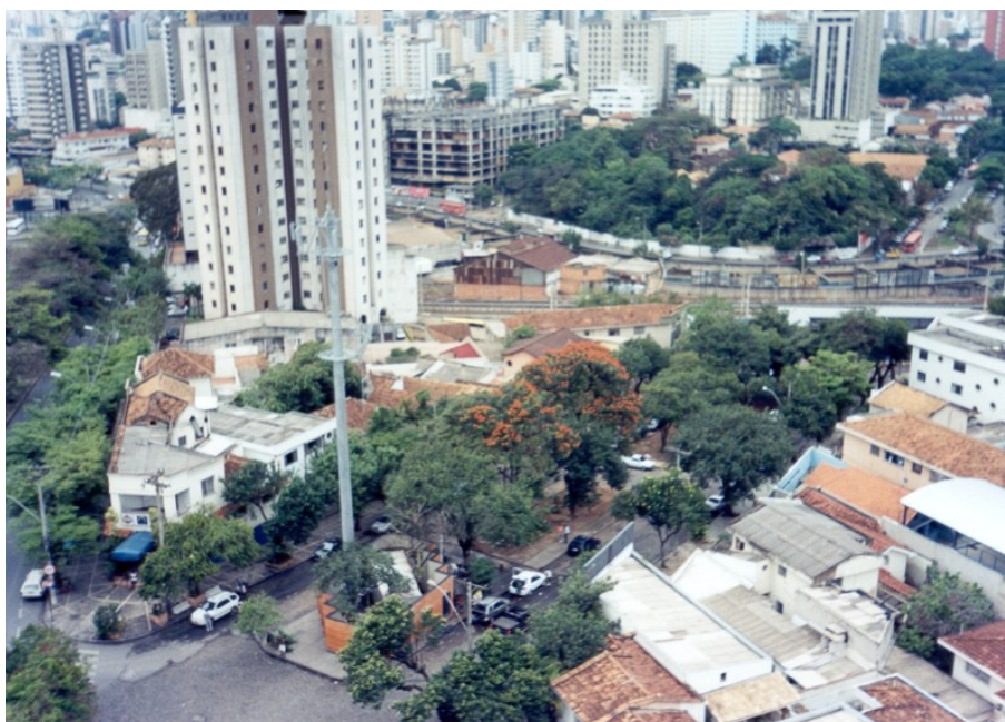
Figura 2.52 Torre de transmissão de telefonia Celular. Av. Bernardo Monteiro, BH.
