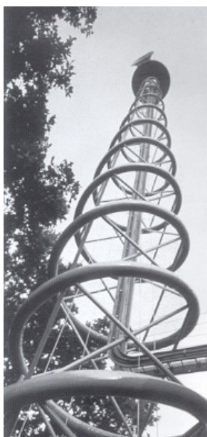
Figura 3.1 Torre de telecomunicações em espiral.
