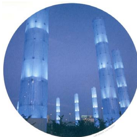
Figura 2.32 Torres de Sinalização para aviões no Lax Airport Los Angeles Fonte: Tzonis , 2002.
