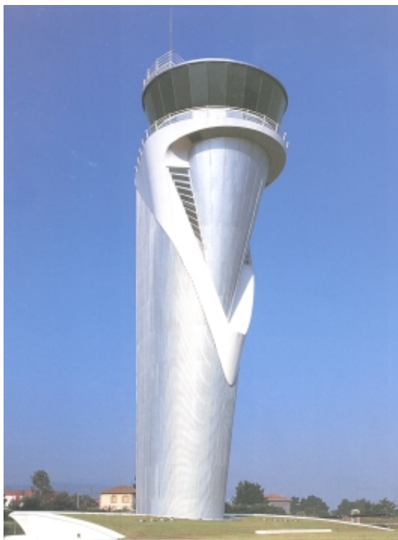
Figura 2.33 Torre de Controle - Sondica Aeroporto de Bilbao- Espanha
