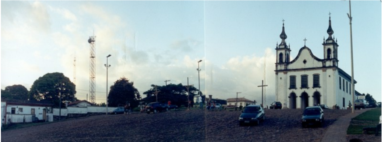
Figura 2.56 Torres de transmissão de telefonia Celular - Catas Altas - MG.
