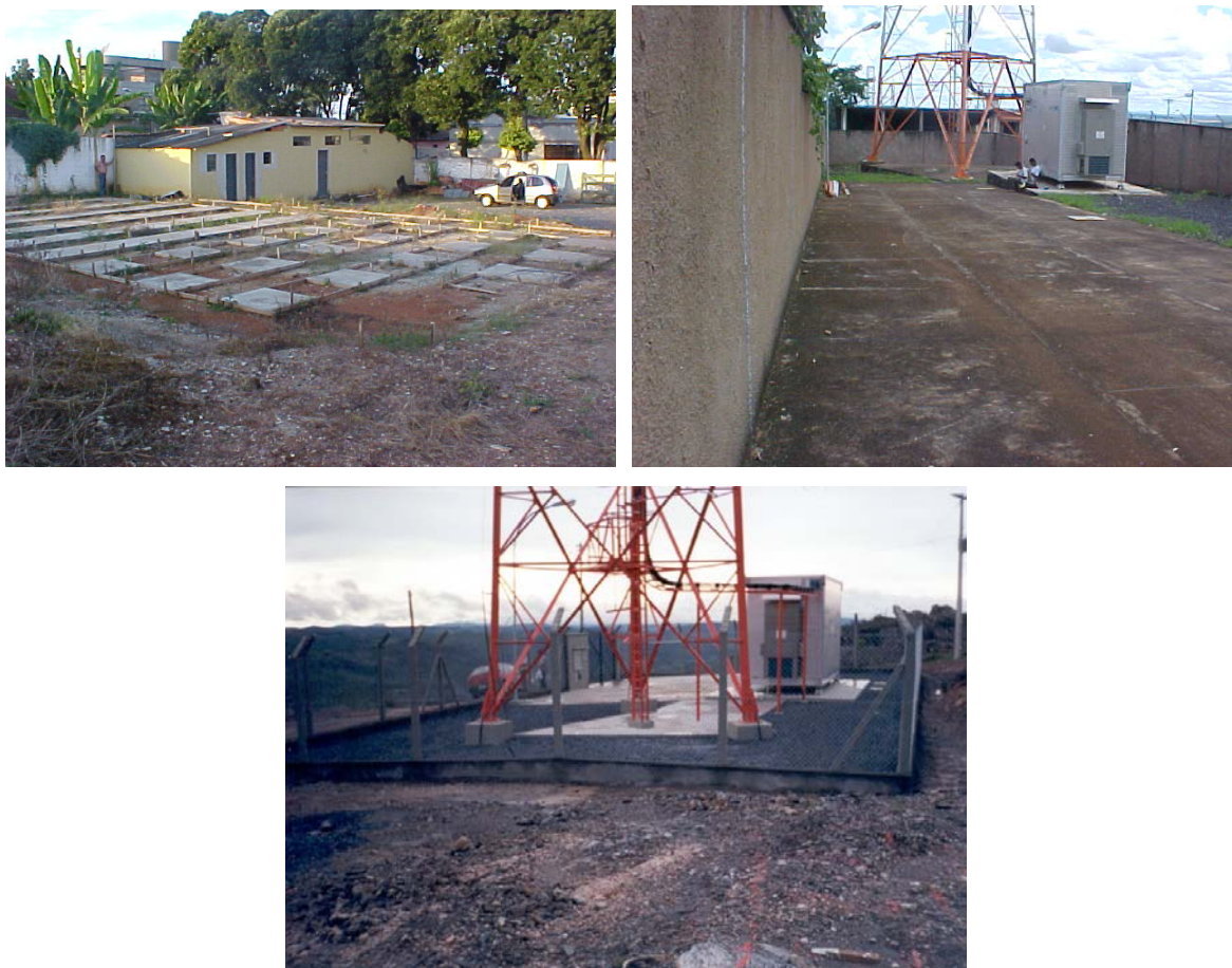
Figura 5.19 - Etapas de implantação de uma torre
