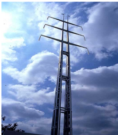
Figura 5.24 - Exemplos de torres com outrigger
