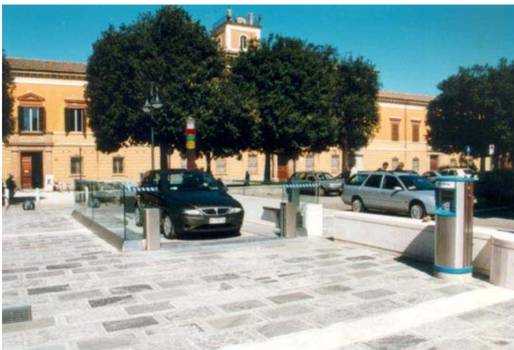
Figura 5.12 - Sistema subterrâneo Trevipark em Cesena - Itália
