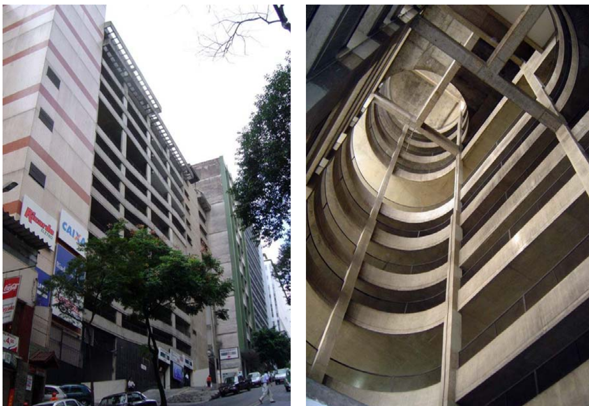
Figura 3.14 - Garagem e rampa interna do Shopping Cidade (vistas externa e interna)
