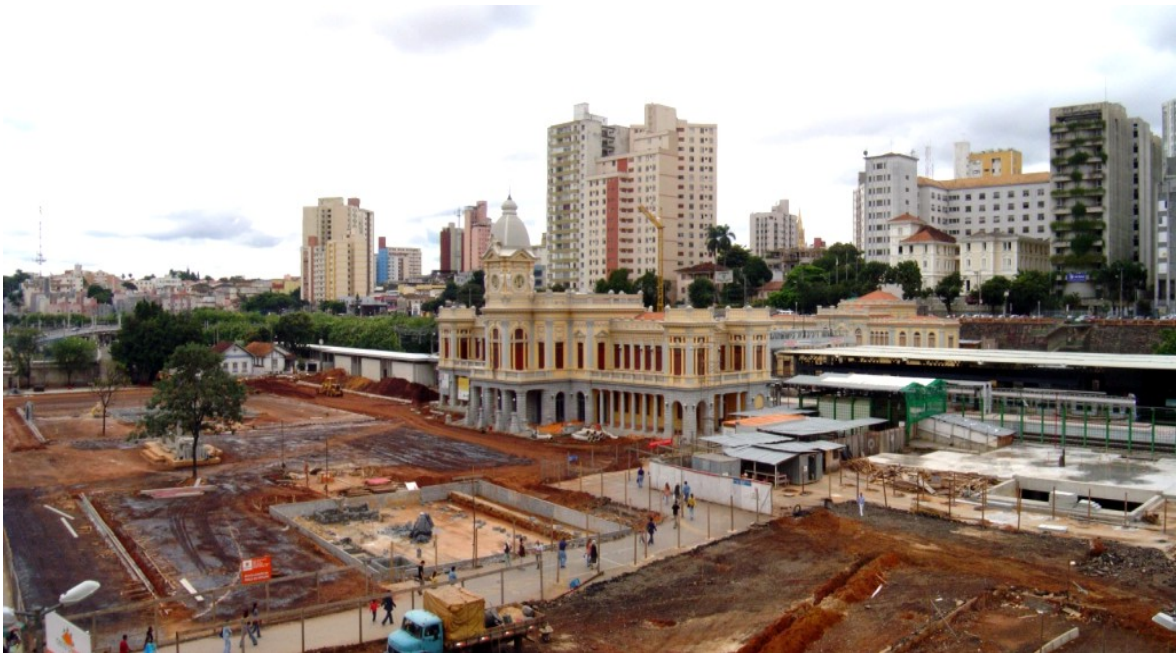
Figura 7.2 - Obras de requalificação da Esplanada da Praça Rui Barbosa – abr 2004
