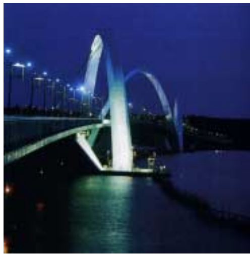
Figura 2.10: Ponte JK (Brasília, 2002)
