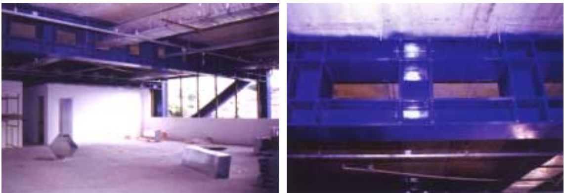
Figura 3.23: Viga Vierendeel
