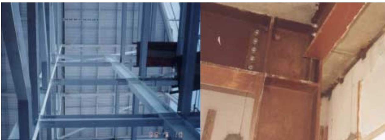
Figura 2.8 - Ligações Rígidas entre Vigas
