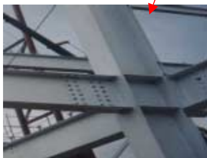
Detalhe da ligação soldada
