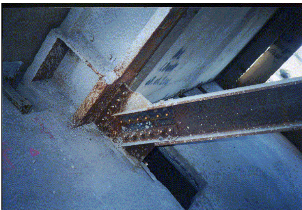
Figura 2.11 - Ligação Flexível em Pórtico Contraventado em Diagonal
