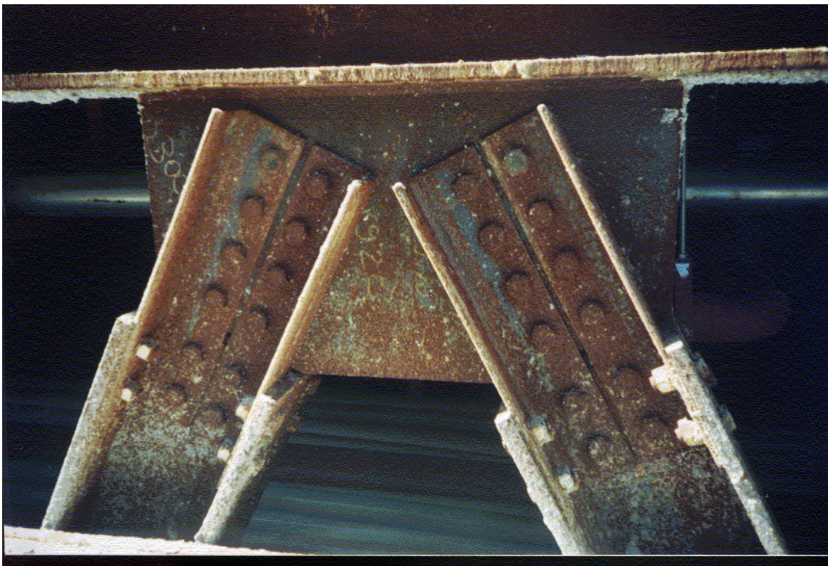
Figura 2.10 - Ligações Flexíveis entre diagonal e Viga.
