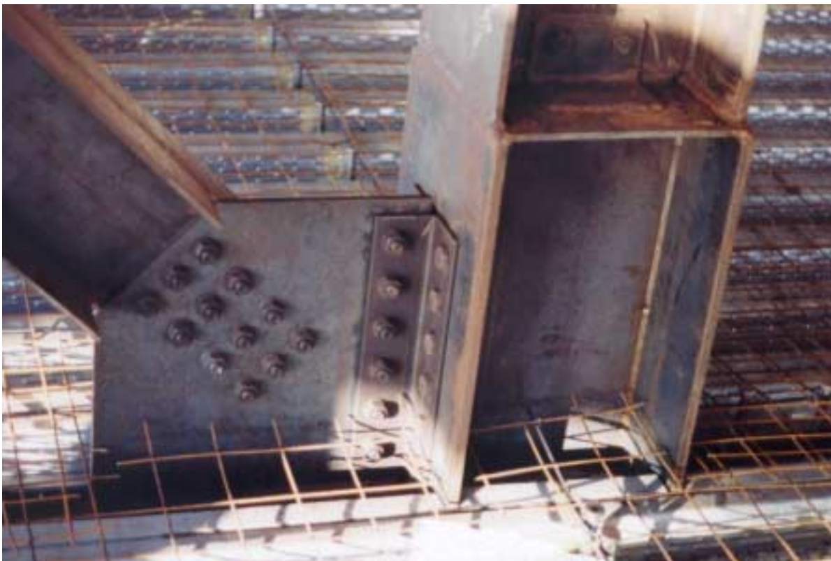
Figura 2.12 - Ligação Flexível em Pórtico Contraventado em Diagonal
