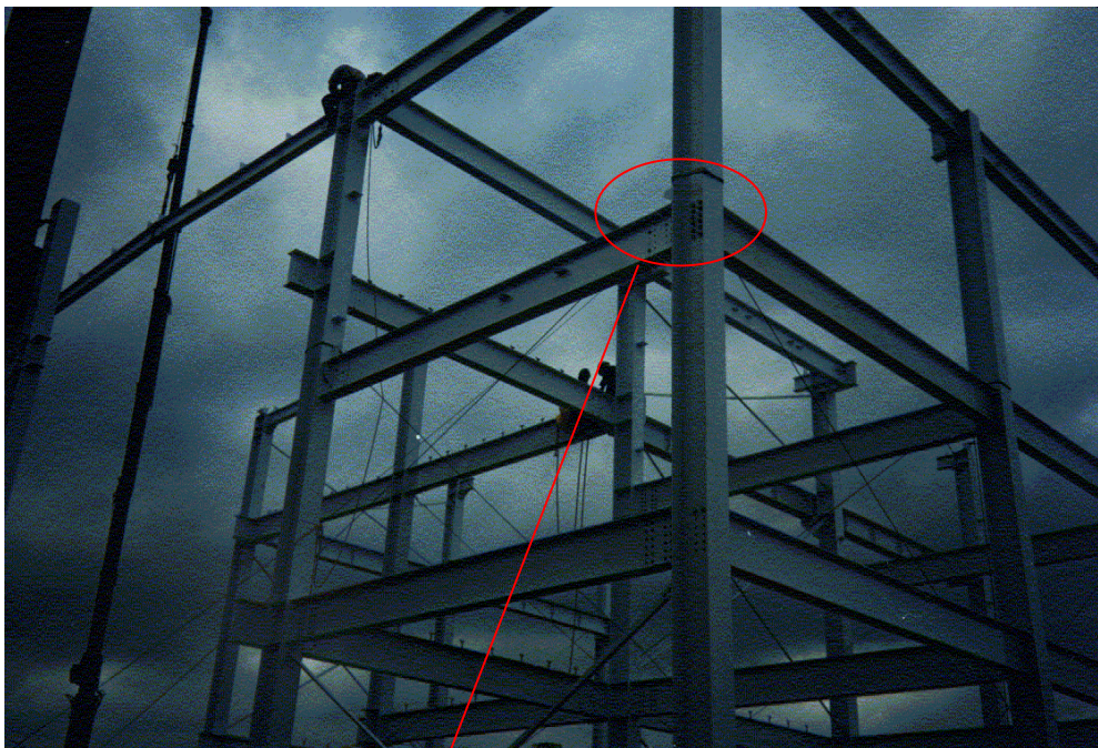
Figura 2.7 - Ligações Rígidas entre vigas e pilares em pórticos Rígidos
