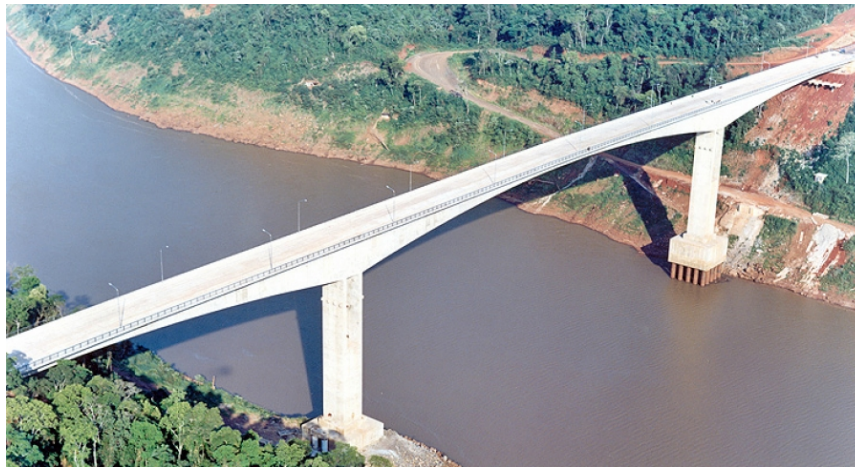
Figura 4.23 – Ponte em Concreto: Fotografia da Ponte Internacional Tancredo Neves
