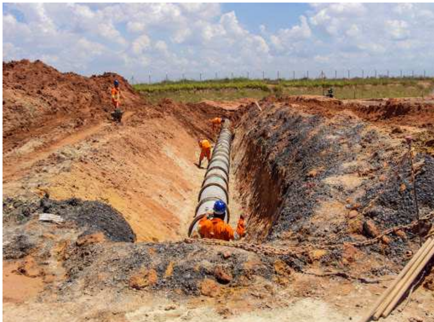
b) Tubulações enterradas http://www.grupoestrutural.com.br
