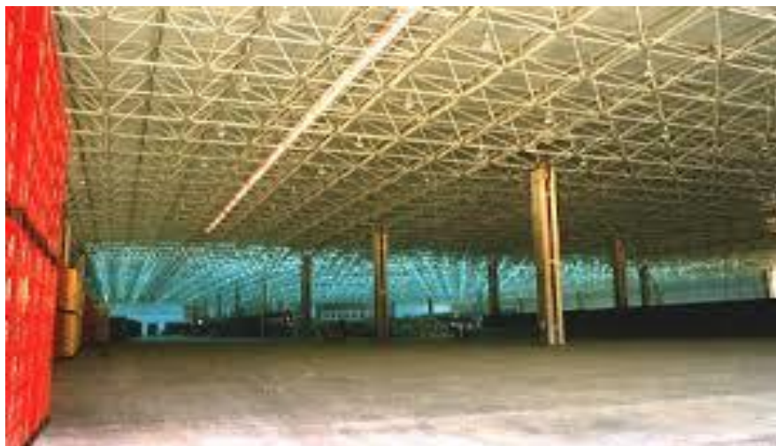
Figura 3.2 Aplicação de treliças espaciais na cobertura da cervejaria Brahma -RJ
