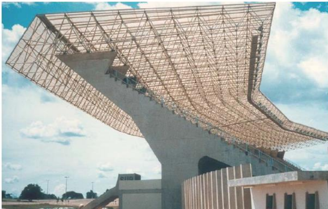
Figura 1.2 – Cobertura do antigo estádio Mané Garrincha, em São Paulo Fonte: Souza, 2002 apud FREITAS, 2008
