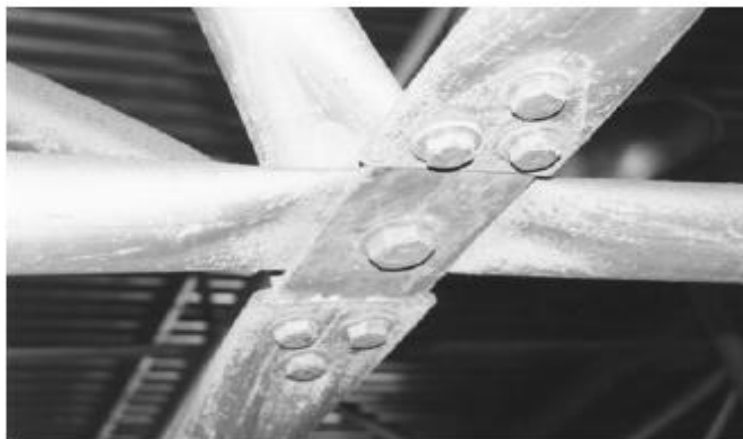
Figura 1.7 – Ligação por nós típicos com chapa complementar Fonte: Souza (2003)
