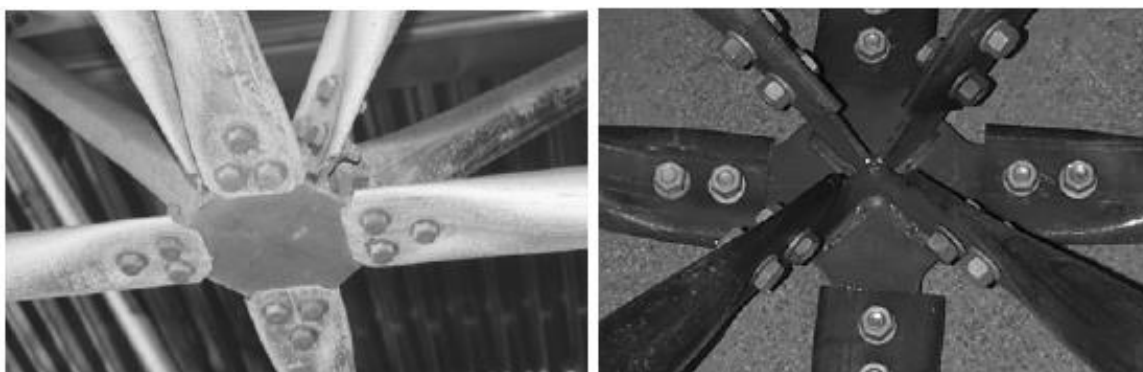
Figura 1.8 – Ligação por nós de aço Fonte: Souza (2003)
