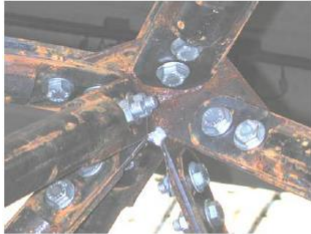
Figura 1.9 – Ligação por nós de ponteira Fonte: Souza (2003)
