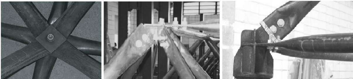
Figura 1.16 - Tipos de nó Fonte: Souza e Gonçalves (2005)
