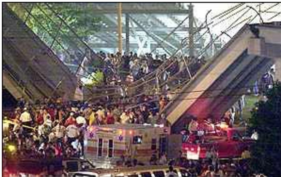
Figura 1. 2. Passarela na Carolina do Norte/EUA logo após o desabamento
