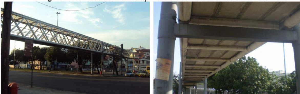
Figura 2. 16. Passarela mista de aço-concreto com conexão não-deformável
