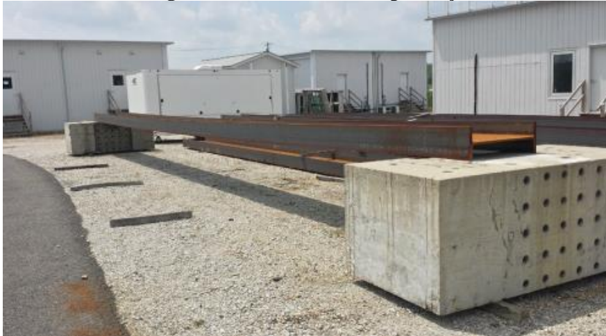
Figura 2. 27. Passarela em viga de aço
