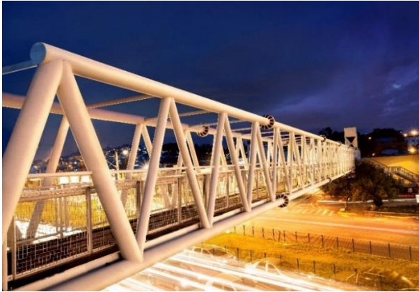
(a) Passarela com estruturas tubulares (Estruturas Tubulares, 2017)
