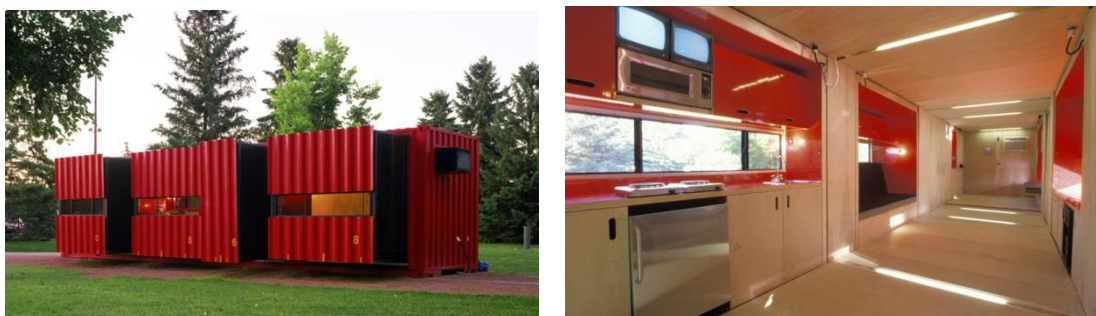
Figura 8 - Mobile Dwelling Unit (MDU) : Vista externa e vista interna
