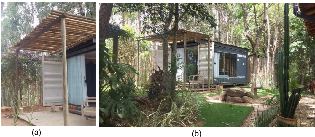
Figura 46 – Edificação C: a) Varanda coberta com bambu e porta do contêiner aberta; b) Vegetação ao redor da edificação
