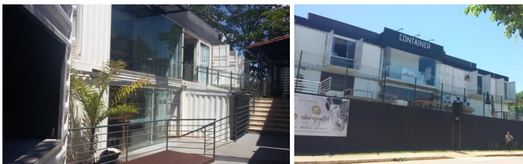
Figura B.5 - Paredes externas em tinta branca, Edificação D
