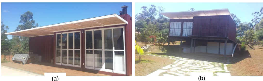
Figura 34 - Edificação A: a) Fachada norte; b) fachada sul
