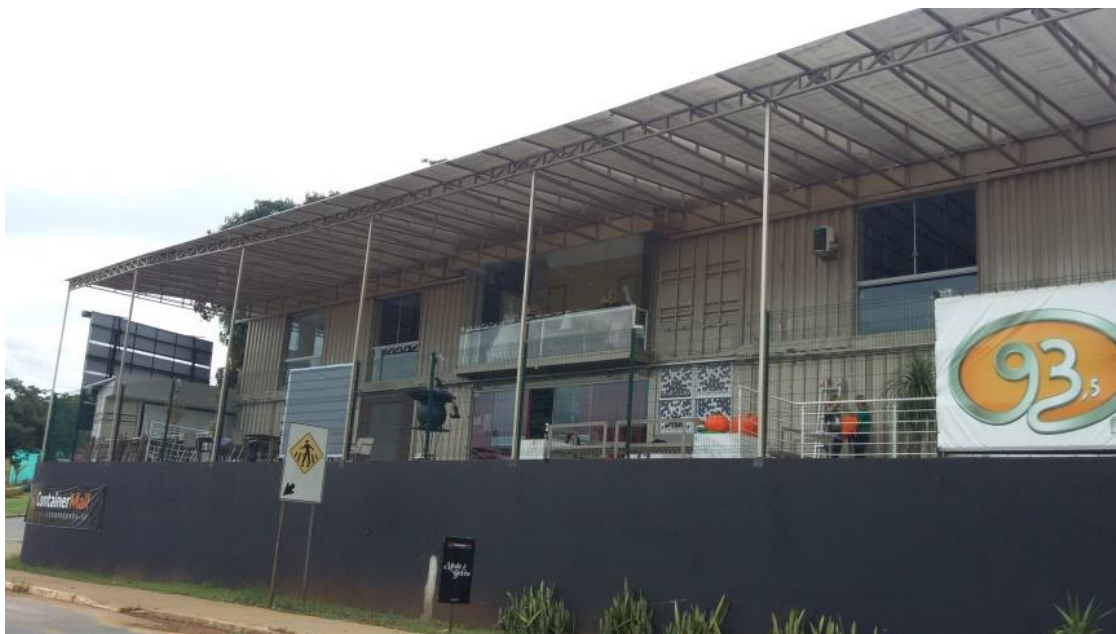
Figura B.6 - Paredes externas da fachada sul com tinta dourada, Edificação D
