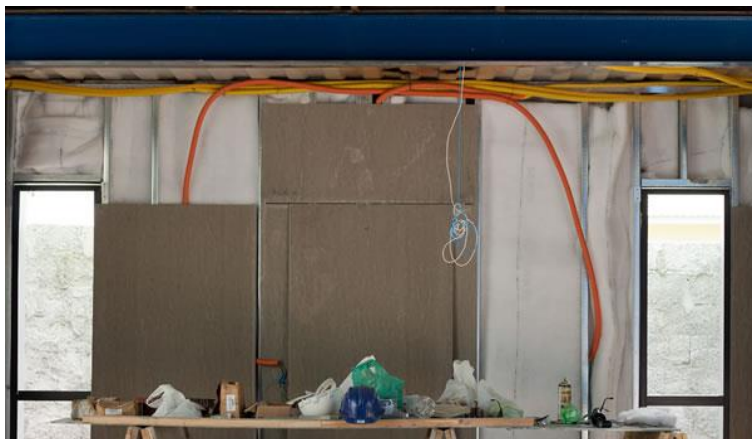
Figura 2.9: Instalações elétricas e hidrossanitárias
