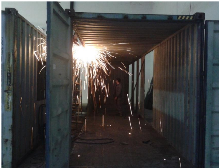
Figura 2.6: Corte com esmeriladora
