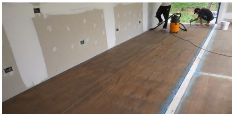
Figura 2.8: Lixamento do piso de contêiner
