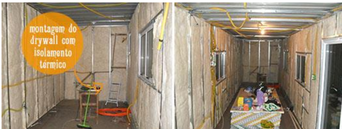
Figura 2.10: Isolamento térmico e acústico com lã de vidro
