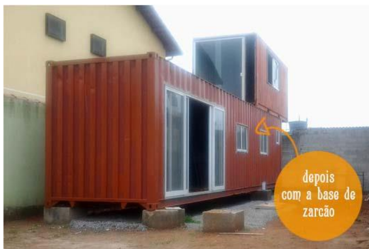
Figura 2.5: Fundação com blocos
