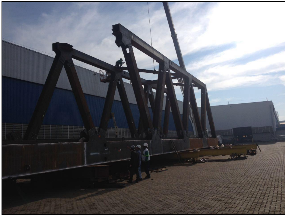
Figura 2.7 – Pré-montagem de uma ponte treliçada em estruturas aço.
