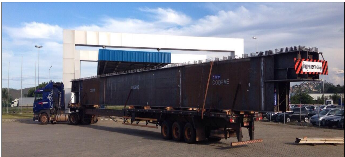
Figura 2.9 – Longarinas de uma ponte metálica sendo transportadas em carretas extensivas.
