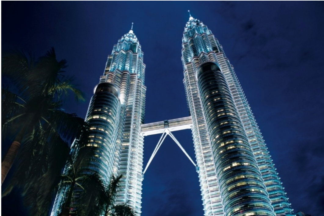
FIGURA 1.1: Twin Towers - Kuala Lumpur - Concreto de 80Mpa até o 60º andar
