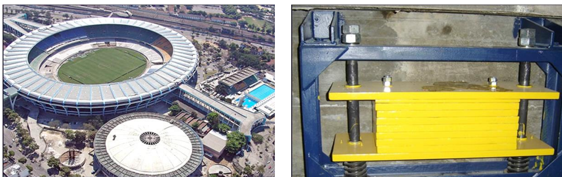
Figura 1.3 – Representação de um dos 10 AMS, figura a esquerda, utilizados para o controle de vibrações do Estádio do Maracanã, figura a esquerda. Retirado de: http://www.controllato.com.br/index.asp
