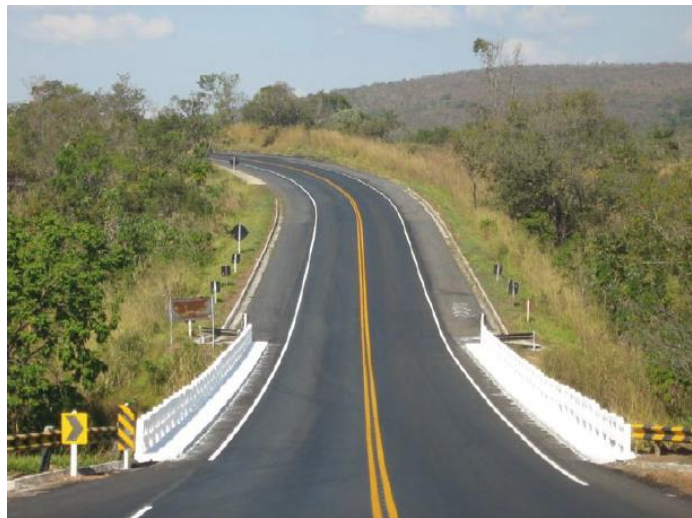
Figura 2.3 – Trecho da BR-040 com Utilização de Brita Zero de Ardósia (Fonte: MICAPEL SLATE, 2016). Disponível em: www.micapel.com
