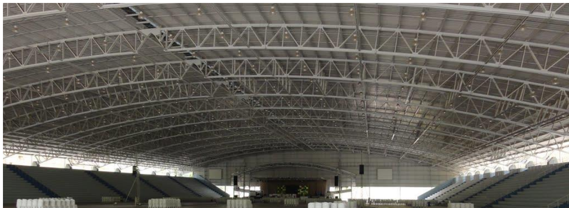
Figura 1.3. Cobertura em arco treliçado vencendo grandes vãos, Brasil.
