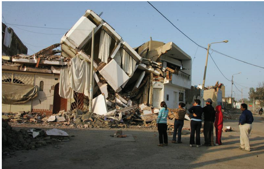
Figura 3.5 – Colapso de edificação devido a vibração excessiva no terremoto em Ica-Perú 2007 ( http://www.elcomercio.pe ).
