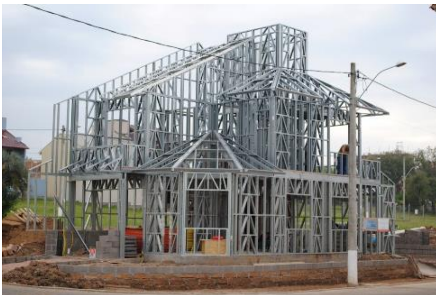
Figura 1 – Estrutura de residência em Light Steel Framing , Porto Alegre/RS.
