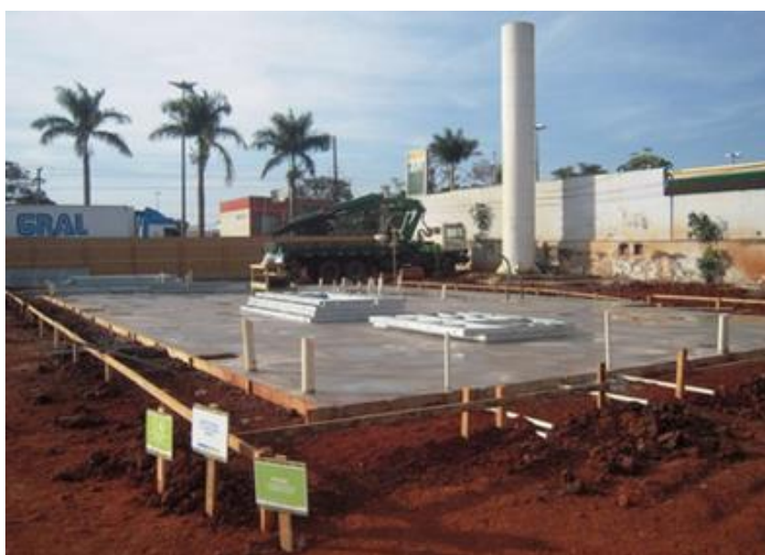
Figura 8 – Fundação do tipo radier
