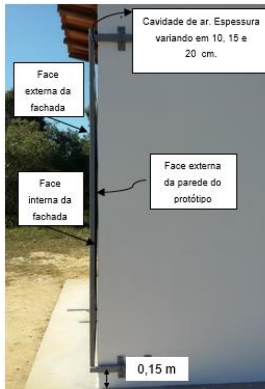
Figura 3.4 – Vista lateral da célula protótipo com a fachada externa
