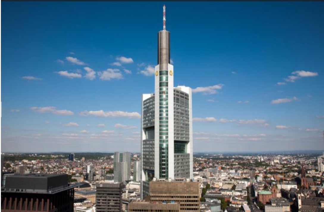
Figura 1.1 - Vista externa do Commerzbank, Frankfurt. Fonte: COMMERZBANK..., 2016
