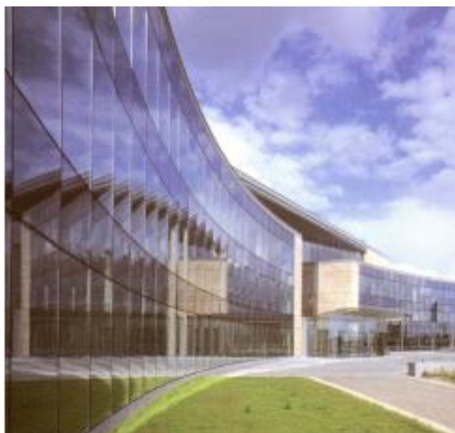
Figura 2.9 - UCB Building, Bruxelas. Fonte: SAELEN, 2002
