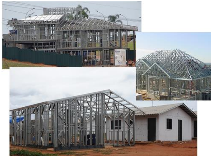
Figura 1. 13 – Obras residências com utilização de perfis formados a frio.
