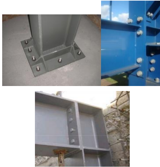
Figura 2. 7 – Tipos de ligações com chapa de topo
