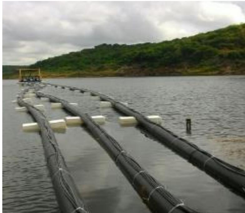
**Figura 1.5** – Adutora de montagem rápida que abastece a cidade Quixeramobim no estado do Ceará
