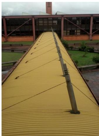
Figura C.6 – Estrutura da cobertura entre os prédios
