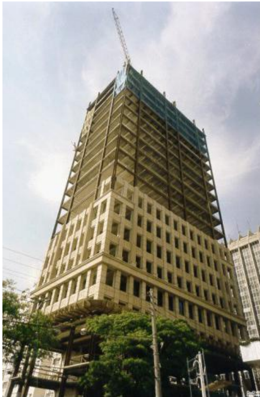
Figura 8 – Edifício San Paolo em fase de construção.
