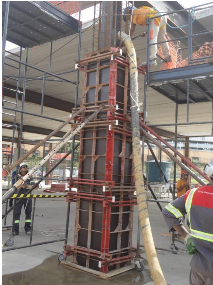
Figura 78 - Detalhe de concretagem da armadura, juntamente com pilar metálico
