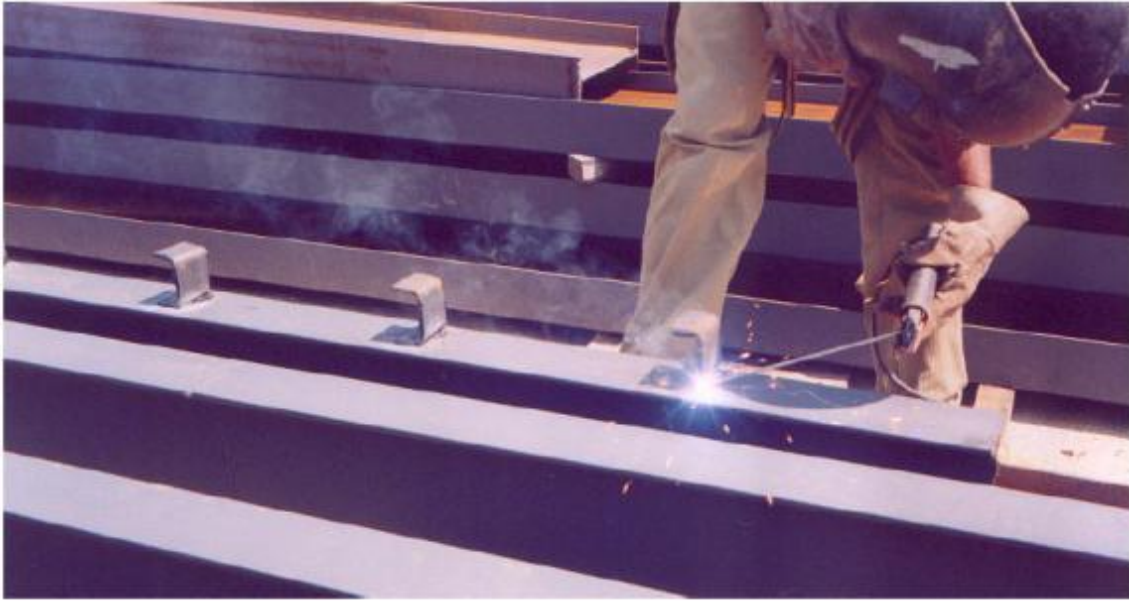
Figura 35 - Soldagem de conectores em perfil U formado a frio
