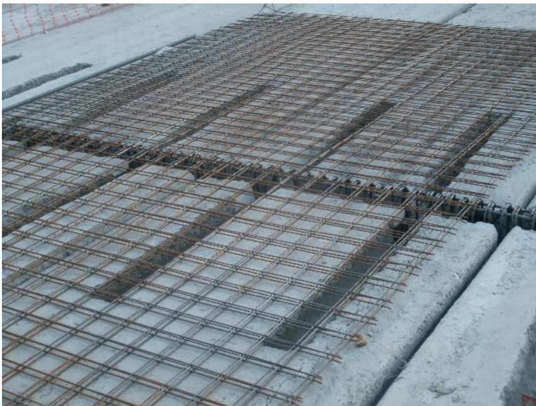
Figura 86 - Conjunto laje alveolar, armadura de capeamento e armadura sobre viga metálica
