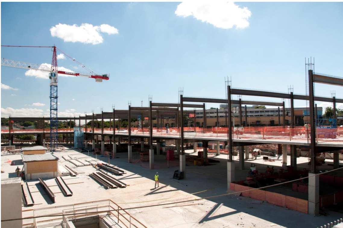
Figura 80 - Sequência de vigas metálicas instaladas
