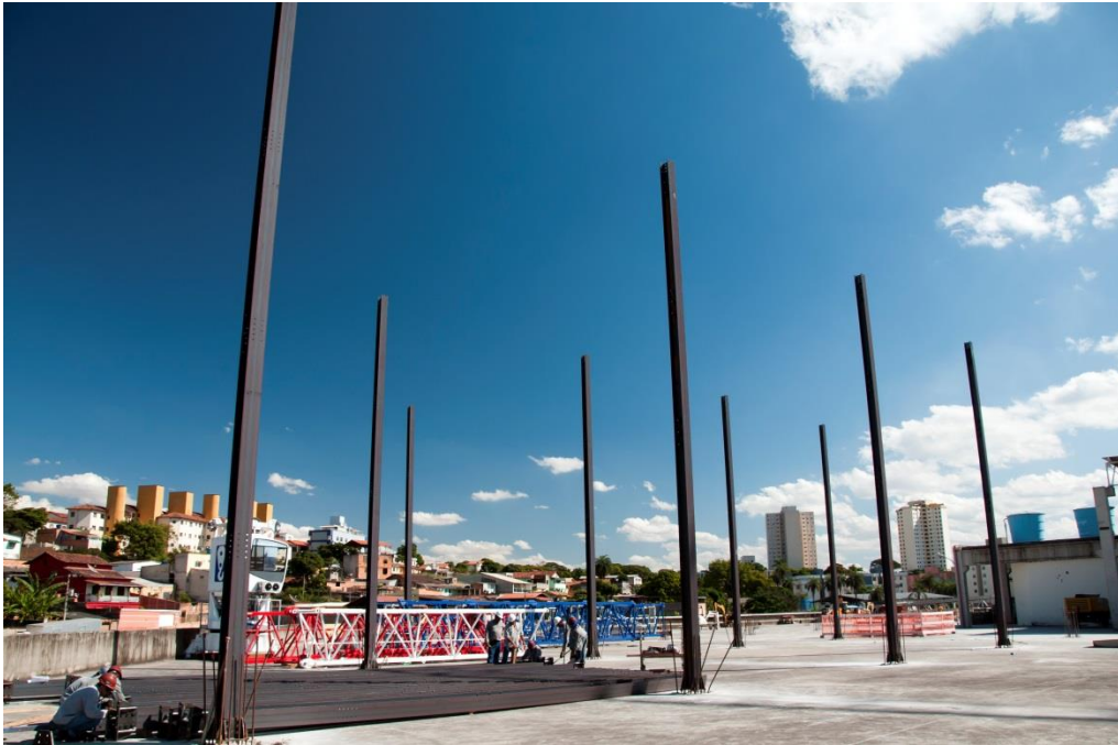
Figura 76 - Conjunto de pilares metálicos instalados
