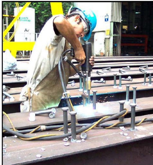
Figura 34 - Soldagem de conectores do tipo pino com cabeça
