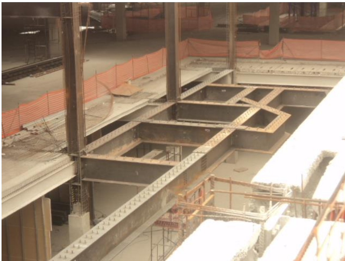
Figura 83 - Perfis soldados para apoio de escada rolante
