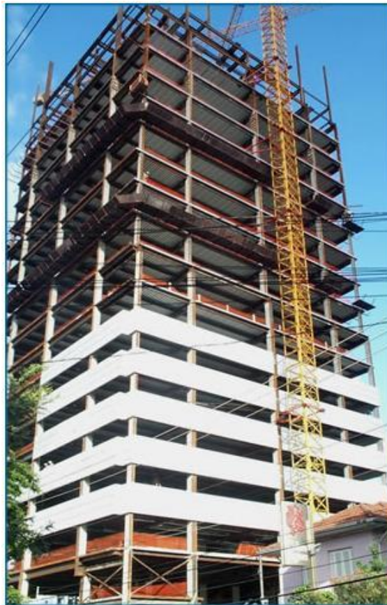
Figura 46 - Construção do edifício
