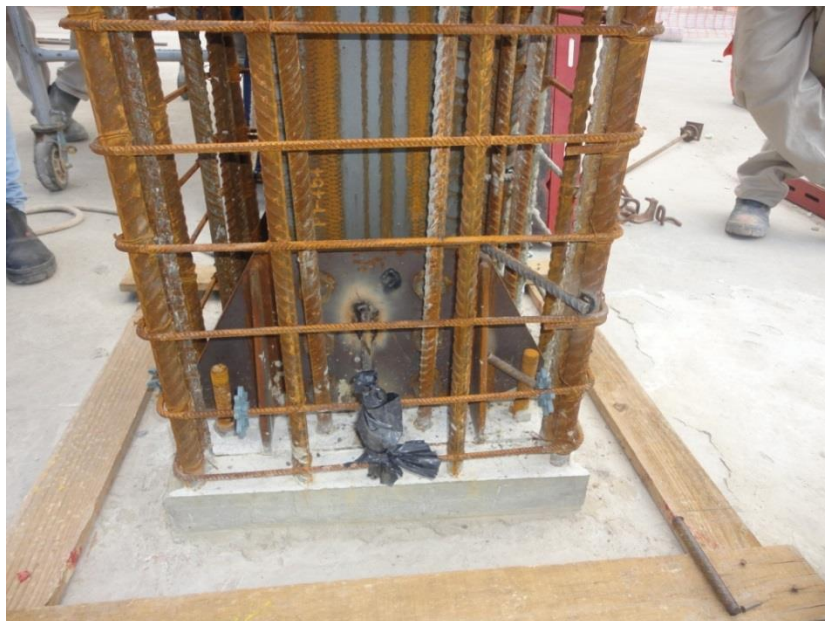
Figura 77 - Detalhe da armadura longitudinal, juntamente com pilar metálico
