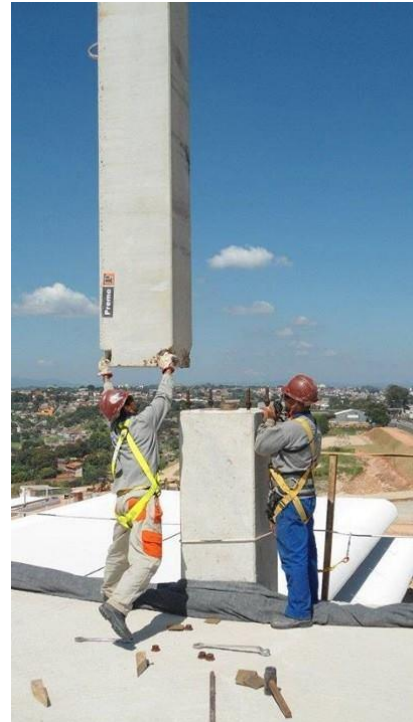
Figura 68 - Pilar pré-fabricado projetado para continuidade.
