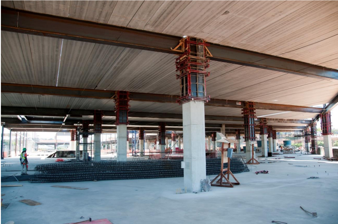
Figura 79 - Concretagem final do pilar
