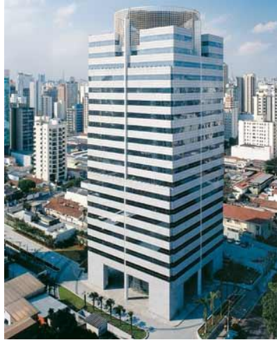
Figura 45 - Edifício New Century
