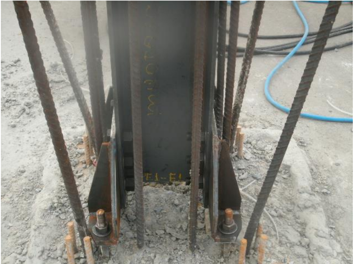
Figura 75 - Detalhe de pilar pré-fabricado e conjunto de ligação executados
