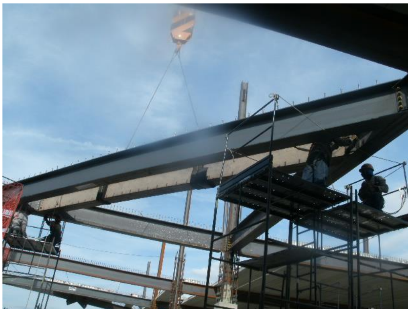
Figura 82 - Instalação de vigas para abertura de “shaft”
