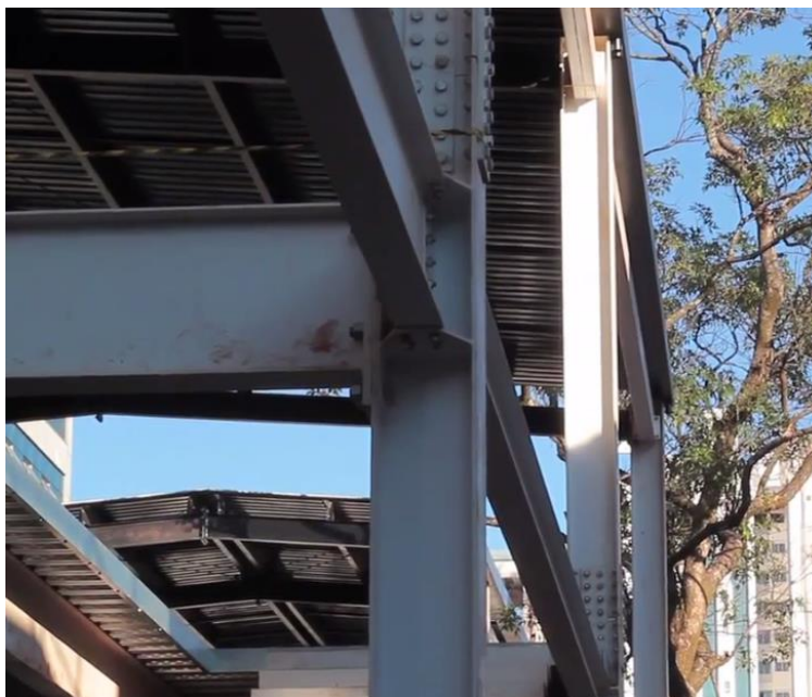
Figura 5.17: Estrutura metálica parafusada.
