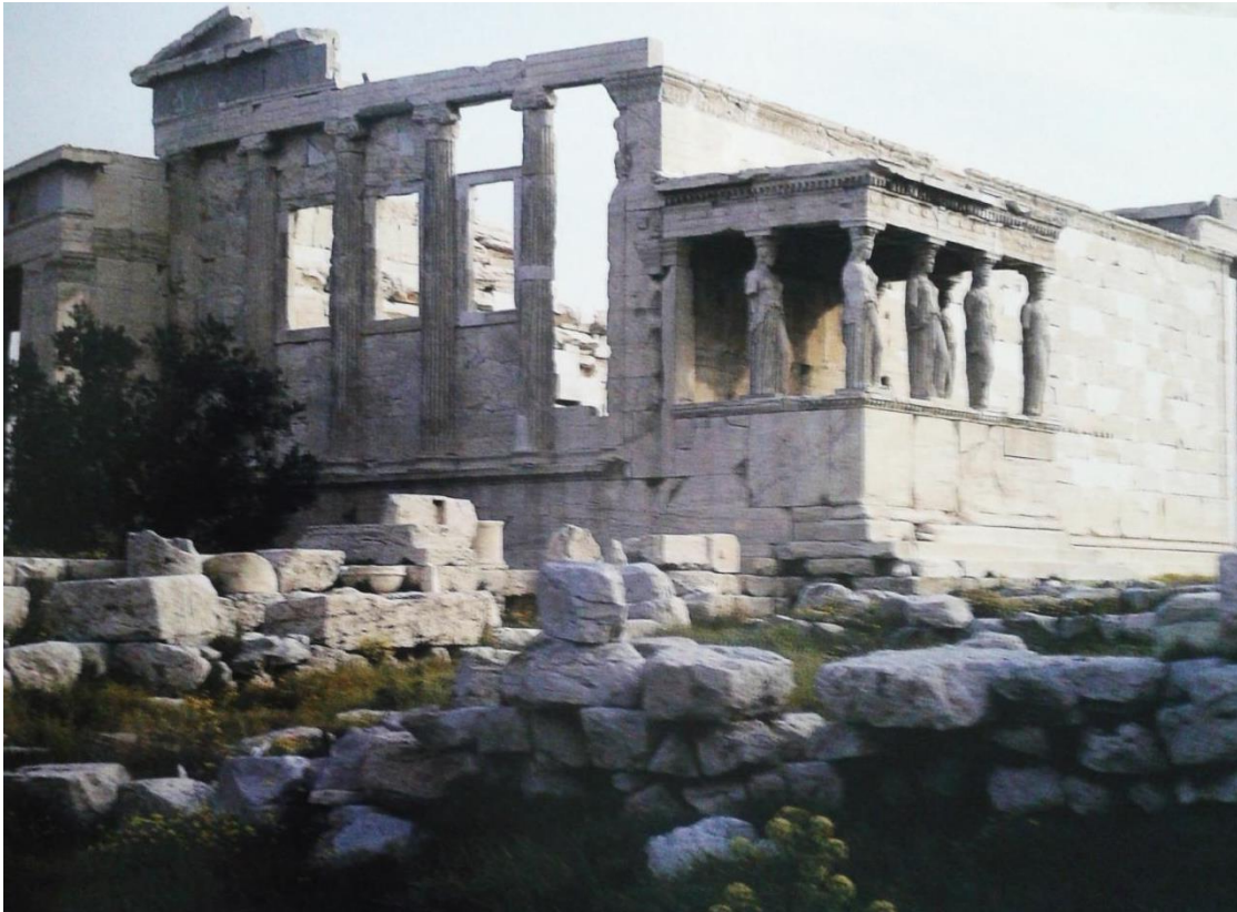
Figura 2.1: Templo Jônico Erecteion, Atenas (421-405).
