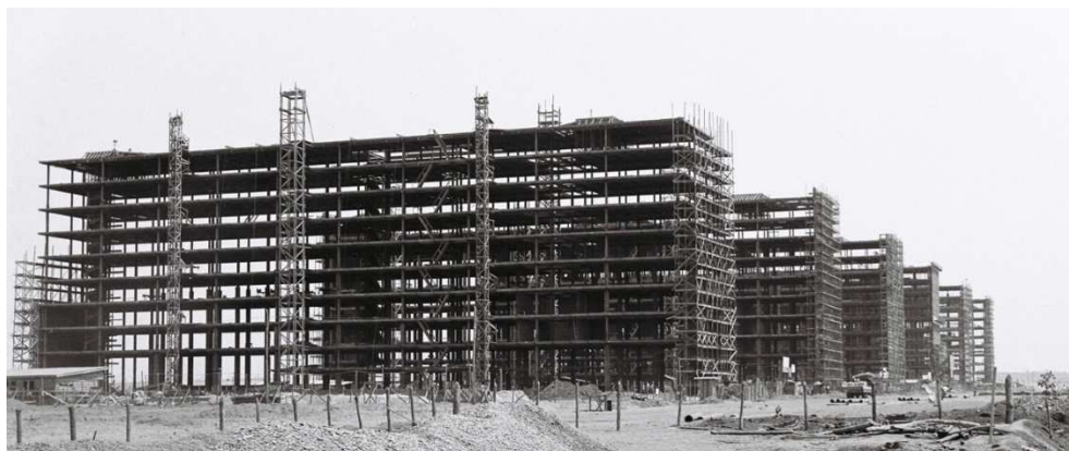
Figura 3.7 - Construção dos edifícios da Esplanada dos Ministérios, Brasília, Distrito Federal Fonte: EDIFÍCIOS..., 2015.
