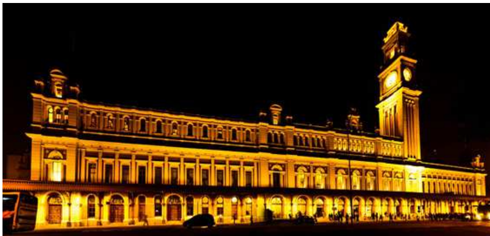
Figura 3.6 - Estação da Luz, São Paulo, capital - estrutura importada da Europa Fonte: ESTAÇÃO..., 2015.
