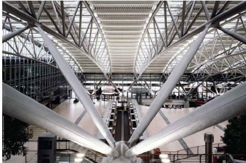
Figura 3.1 – Cobertura do aeroporto de Hamburgo, Alemanha (V&M DO BRASIL, 2008).
