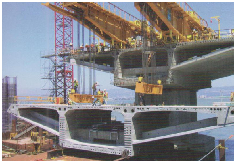
Figura 3.2 – Vigas de concreto pré-moldado sendo instaladas no Skyway Segment, ponte que liga as cidades de Oakland e San Francisco, California, EUA (METHA & MONTEIRO, 2014).
