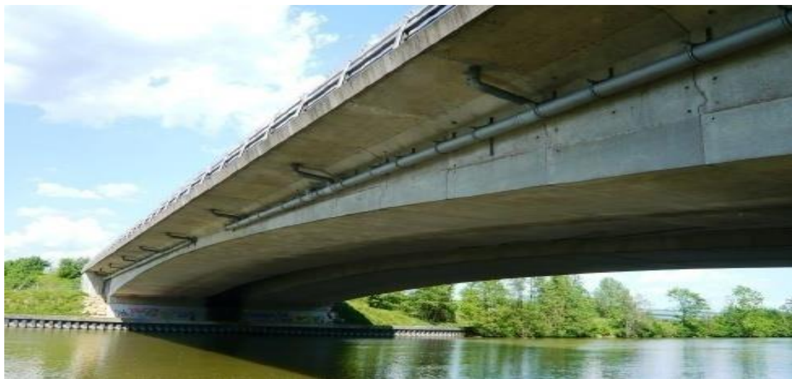
Figura 38 - Ponte PI-57. Fonte: Cury (2010)
