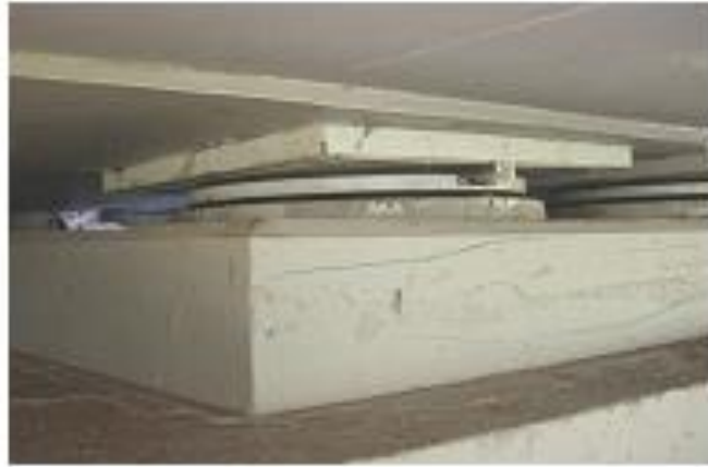
Figura 5.22 –Aparelho de apoio guiado utilizado na Ponte de São Lourenço.
