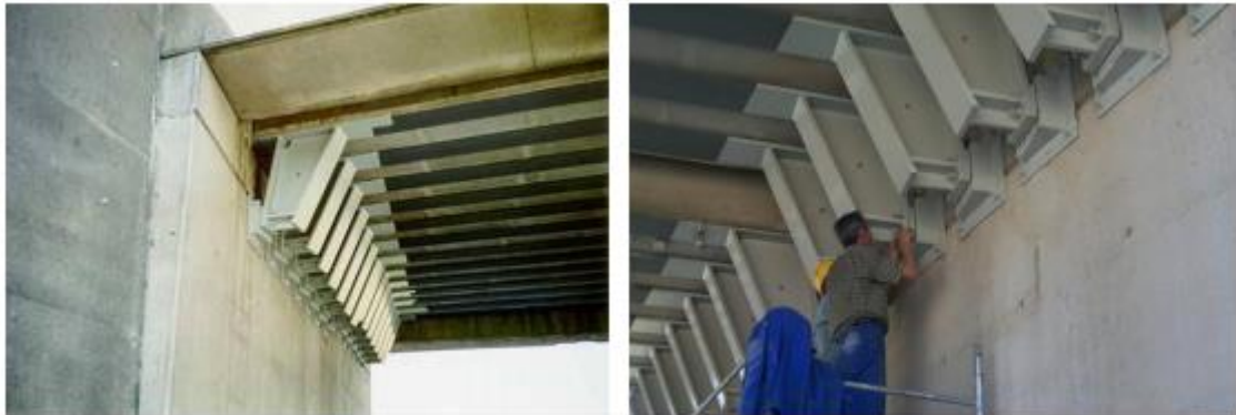
Figura 4.7 a,b – Detalhe dos mancais e procedimento de reforço. Fonte – Cury, 2010.
