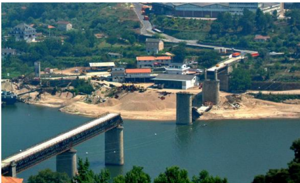
Figura 1.9 – Ponte Hintze Ribeiro após o colapso. Fonte – Branco, 2013.
