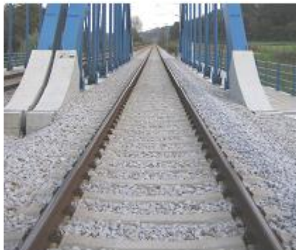
Figura 5.23 – Vista geral da via ferroviária. Fonte – Ribeiro, 2012.
