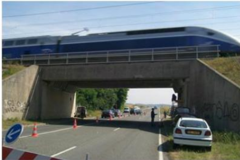
Figura 4.5 – Vista geral do viaduto. Fonte – Cury, 2010.
