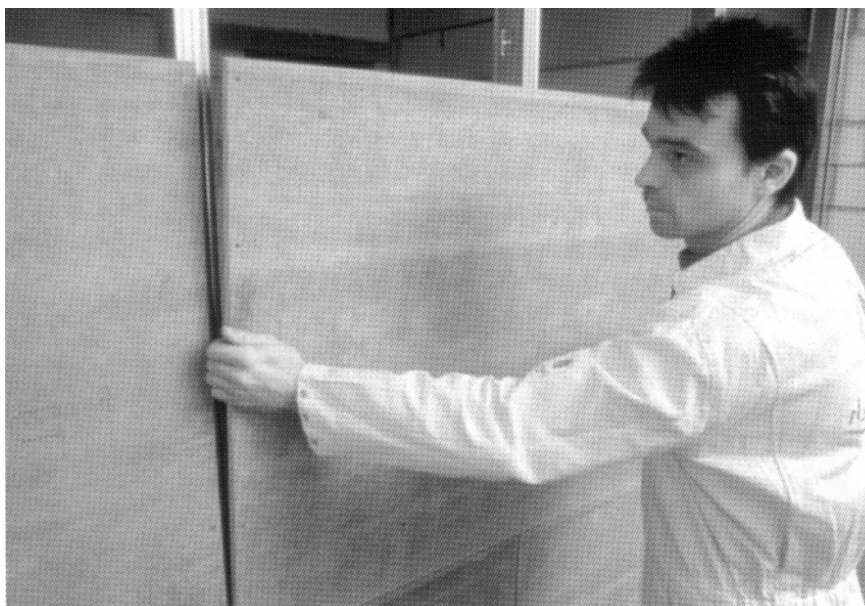
Figura 2.4 – Sistema de placas cimentícias (Knauf, 1999)
