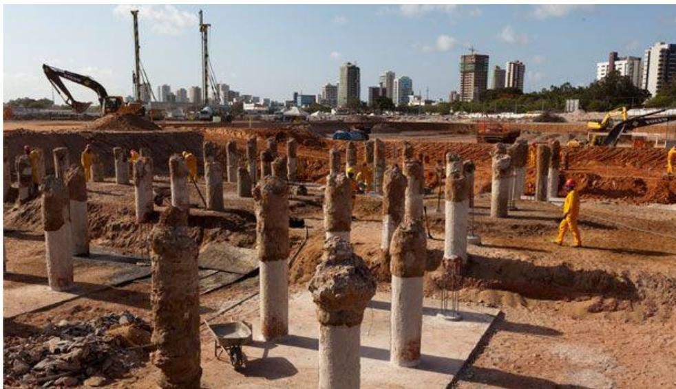
**Figura 1.4** Elementos de fundação: estacas (piniweb.pini.com.br)
