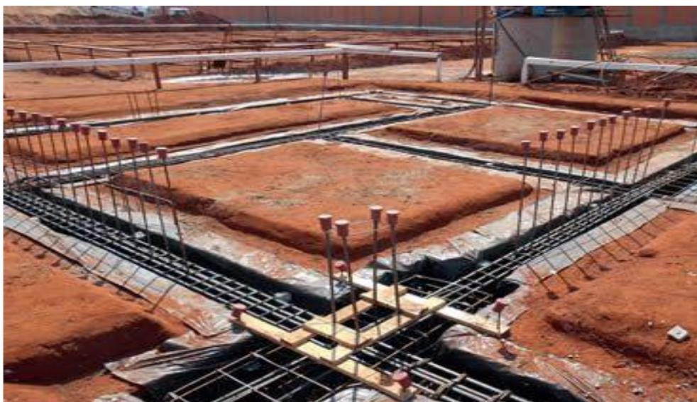
**Figura 1.5** Elementos de fundação: baldrames (construcaomercado.pini.com.br)
