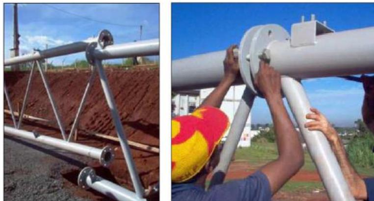
Figura 1.3 - Ligação flangeada em sistemas treliçados (FONTE: SAMARRA, 2007).
