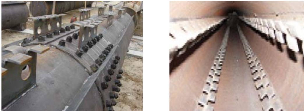
Figura 2.17 - Vista dos conectores externos e internos (Chin et al. , 2008)
