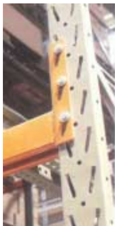
Foto 3.3. Ligação parafusada com fixação na alma da coluna, (Águia (1999a)).
