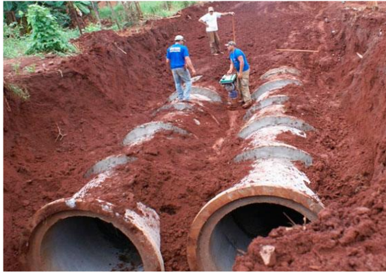
(a) Tubulação enterrada http://www.geraldoresende.com.br
