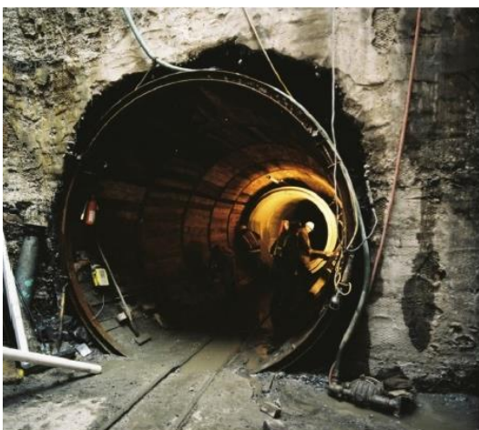
c) Contenção para túneis (Eller, 2009)
