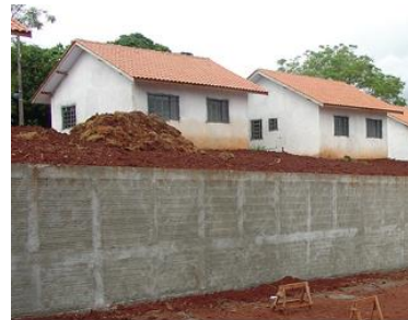
b) Muro de arrimo (angelorigon.com.br)
