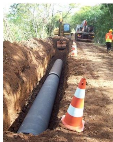
d) Tubulação enterrada (londrina.odiario.com.br)
