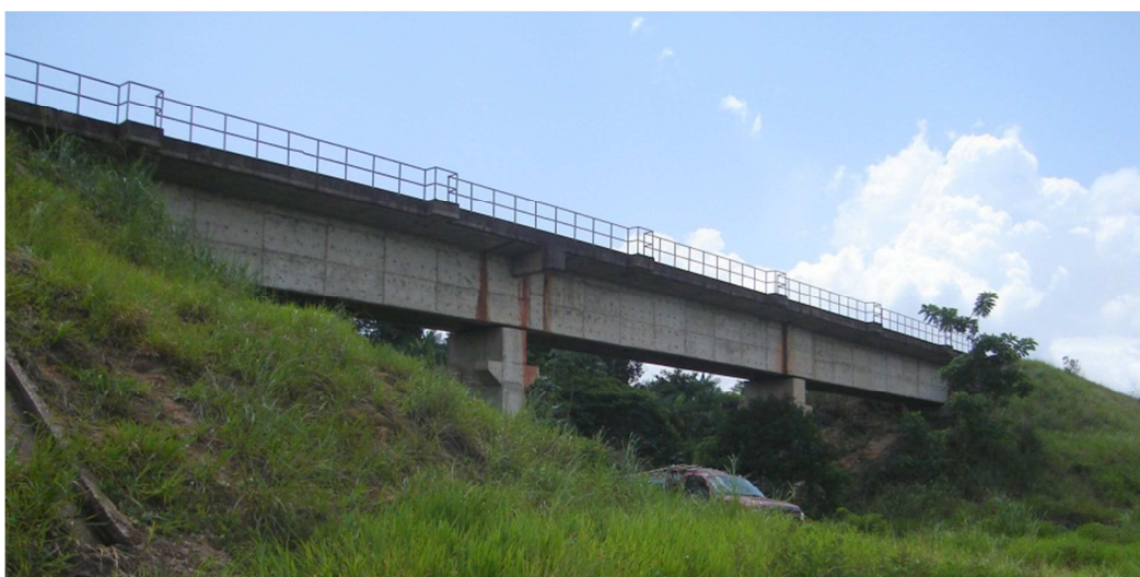
Figura 4.2 Vista lateral direita da ponte (Rodrigues Júnior et al. , 2012)
