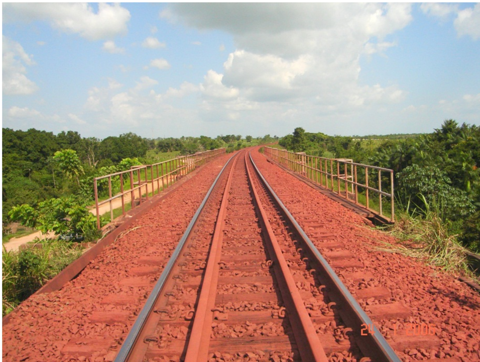
Figura 4.1 Tabuleiro da ponte sobre o Rio Martório (Rodrigues Júnior et al. , 2012)
