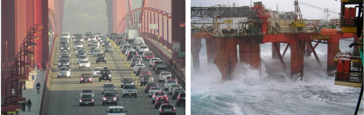
Figura 7. Excitação ambiente. (a) tráfego em uma ponte, (b) ondas que impactam em uma plataforma offshore. Fonte: Panoramio (2011).
