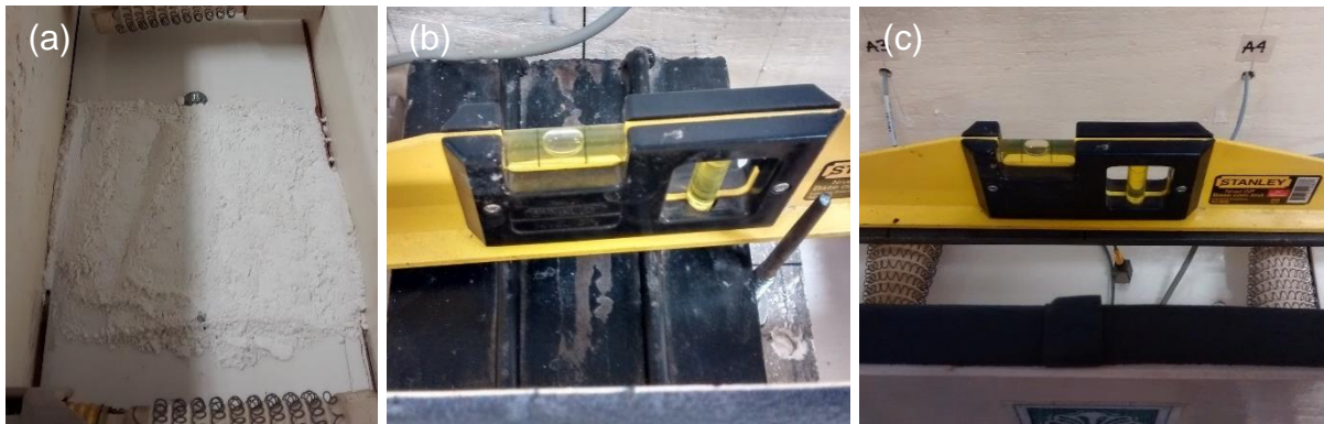
Figura 32. (a) Camada de gesso, comprovação da horizontalidade de: (b) apoios, (c) viga.
