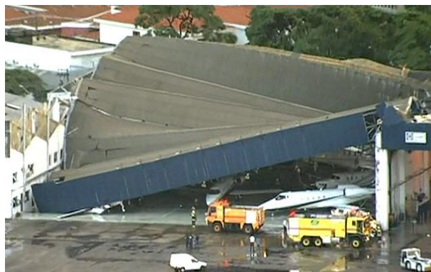
Figura 4. Teto do Hangar que desabou no aeroporto de Congonhas em São Paulo. Fonte: Folha de Sao Paulo (2015).
