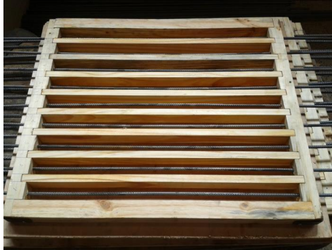
Figura 3.16: Fôrmas dos tirantes
