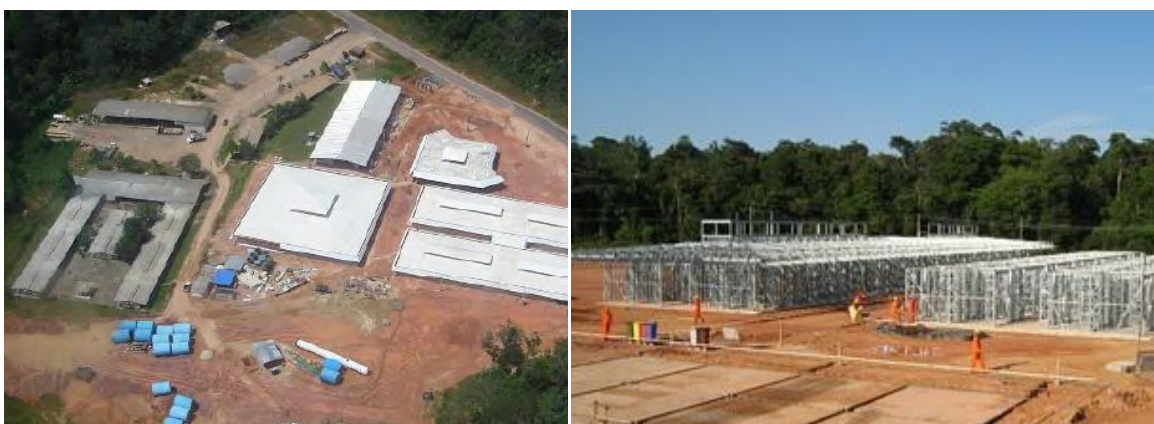
Figura 6.11-Obras em Urucu, AM
