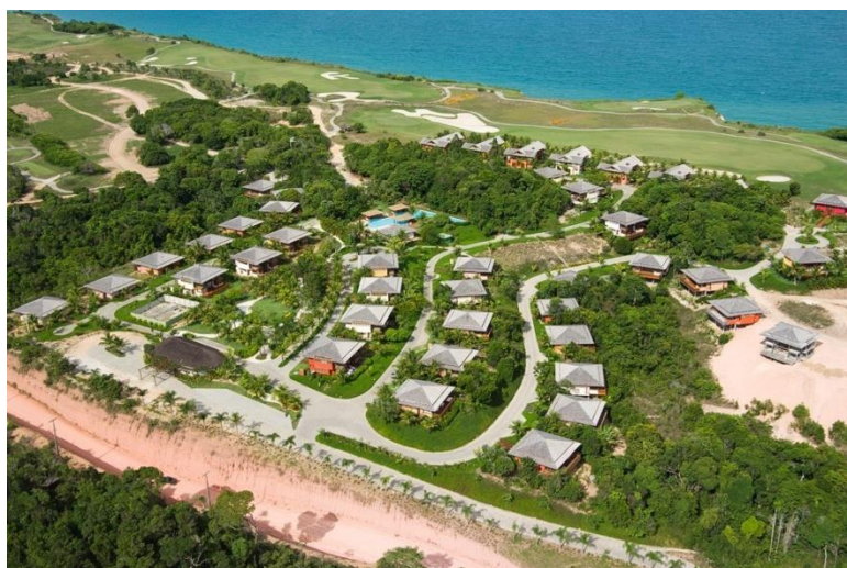
Figura 6.7-Condomínio Terravista - Trancoso - BA
