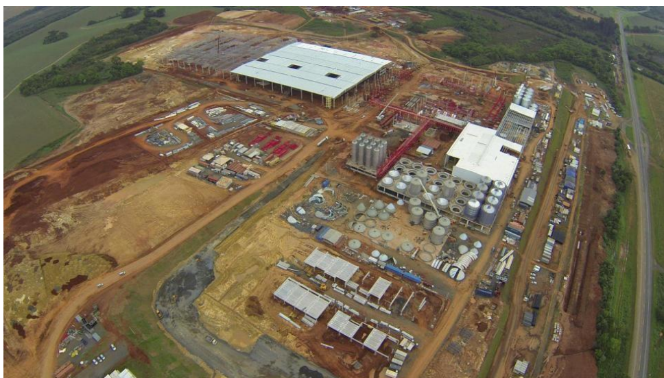
Figura 6.29 -Fábrica da AMBEV em construção
