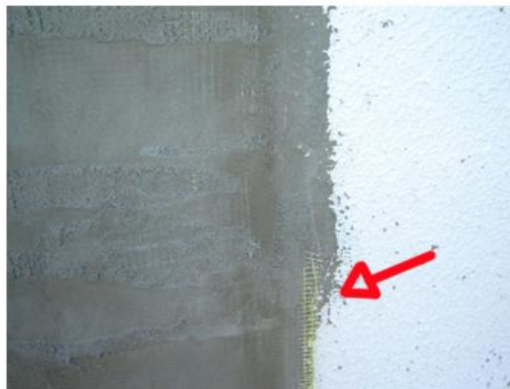
Figura 6.19 -Tela de fibra de vidro ProFort Base Coat System sobre massa
