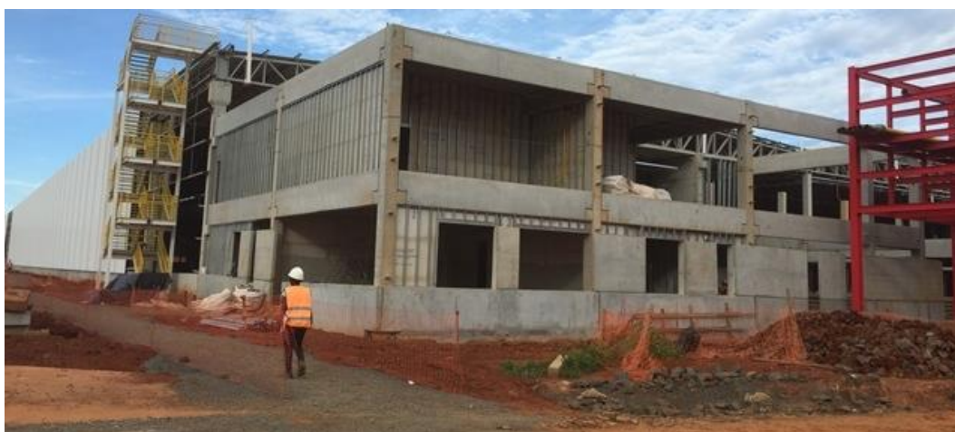
Figura 6.30 - Fábrica da AMBEV em construção
