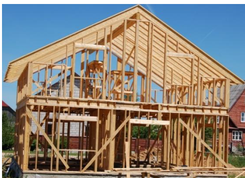
Figura 2.4 - Construção em wood frame
