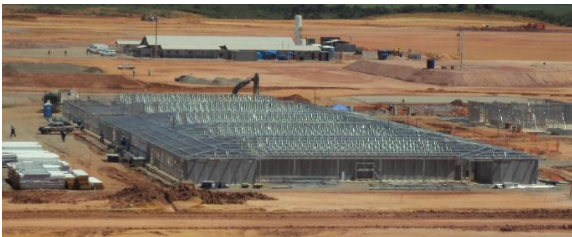
Figura 6.10 - Obra da Petrobrás – COMPERJ em Itaboraí, RJ
