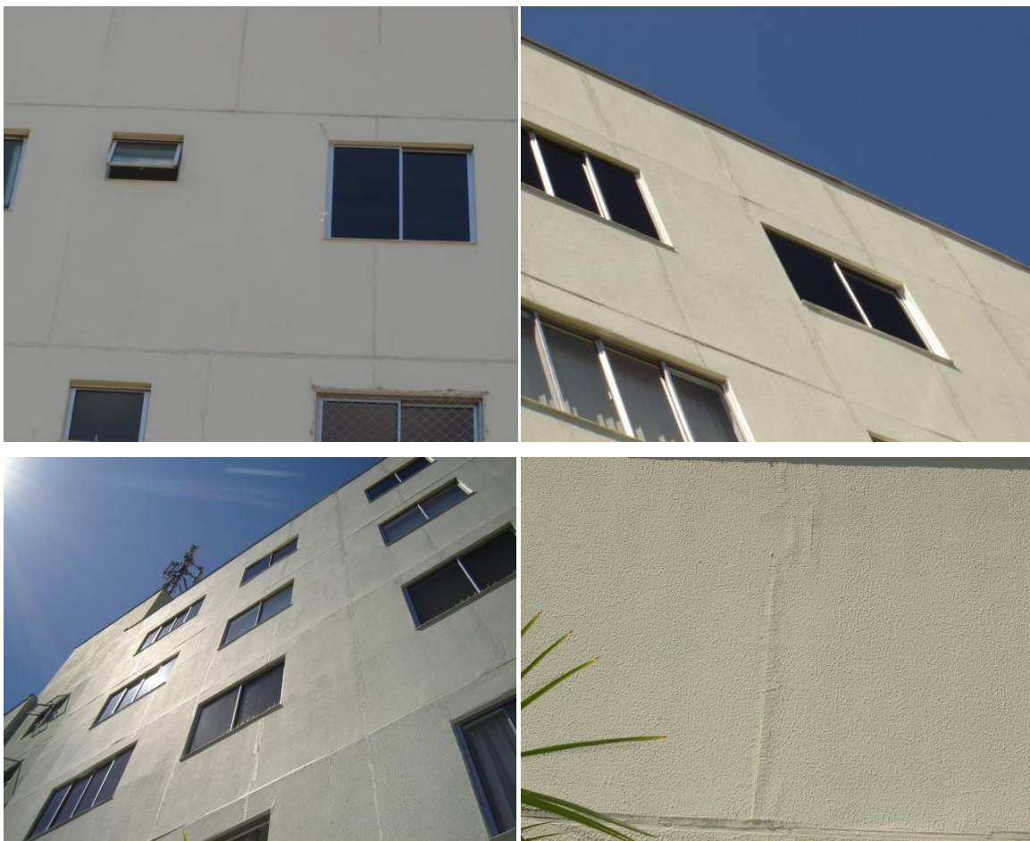
Figura 5.2 - Fachada de edifício em LSF
