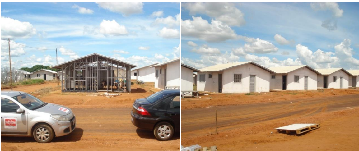
Figura 6.6 - Construção MCMV em Uberaba
