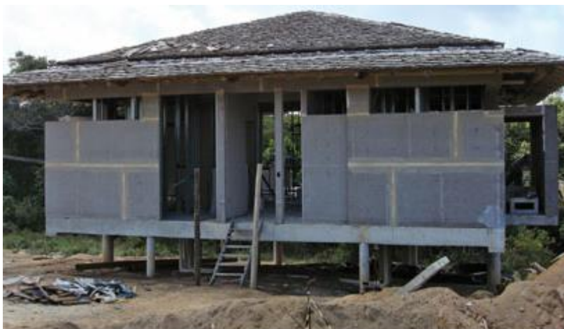
Figura 6.8 - Casa em obra no Condomínio Terravista
