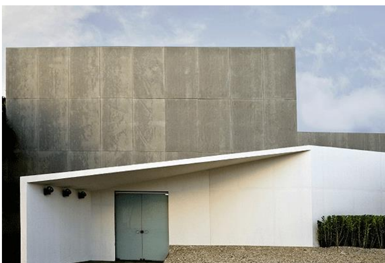
Figura 5.3 - Fachada com placas cimentícias aparentes
