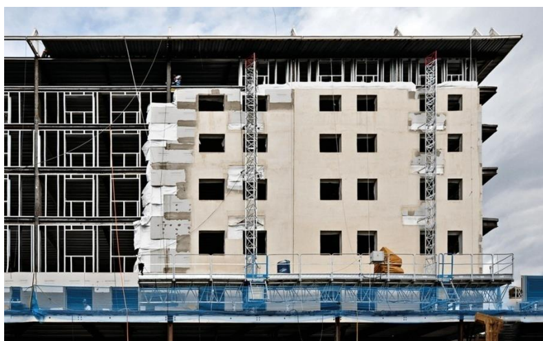
Figura 6.18 - Fachada com Aquapanel
