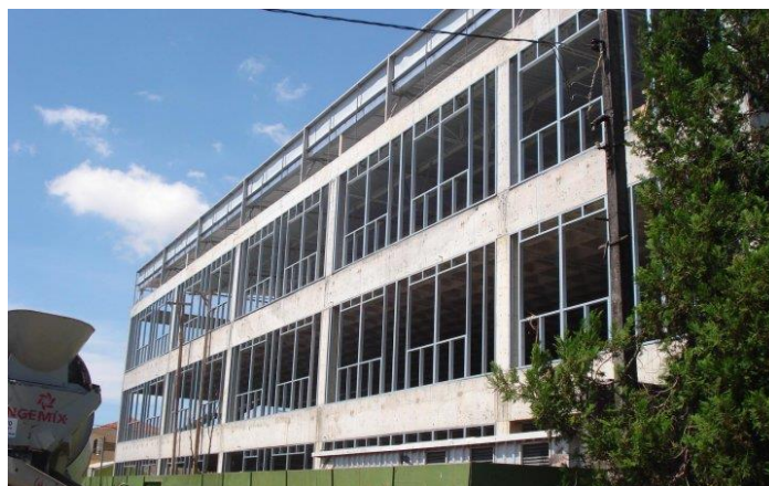
Figura 6.25 - Edifício da empresa Processo Industrial - Pinhais, PR
