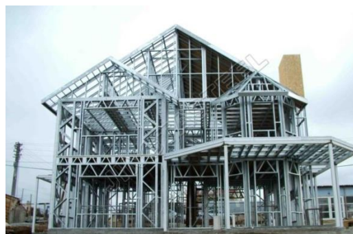
Figura 2.5 - Construção em light steel framing
