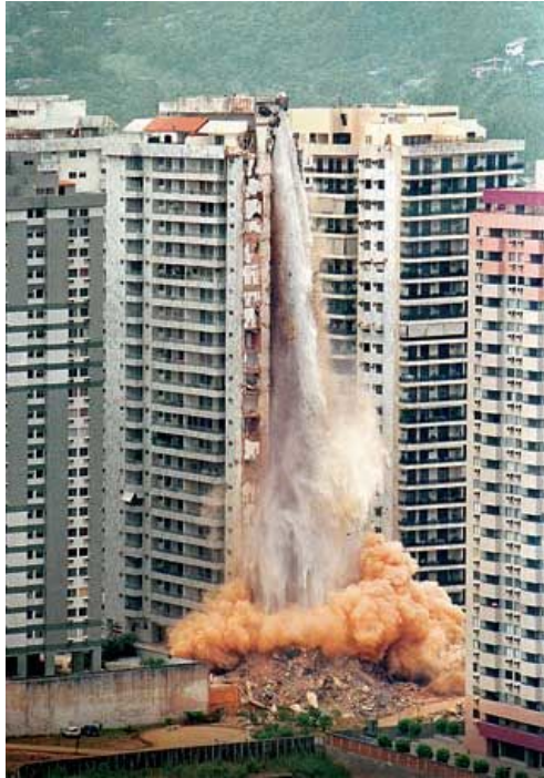
Fig. 1.11. Palace II collapse [28]
