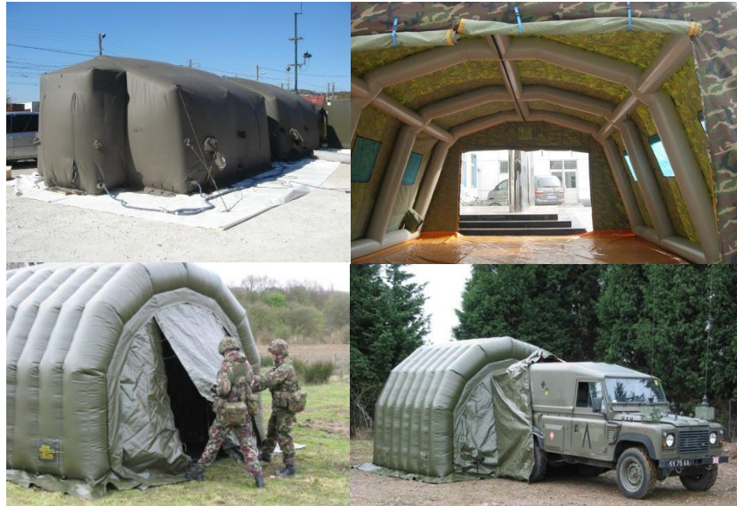
Figura 3.24: Abrigos militares pneumáticos. Fonte: ARMED FORCES INT., 2014.
