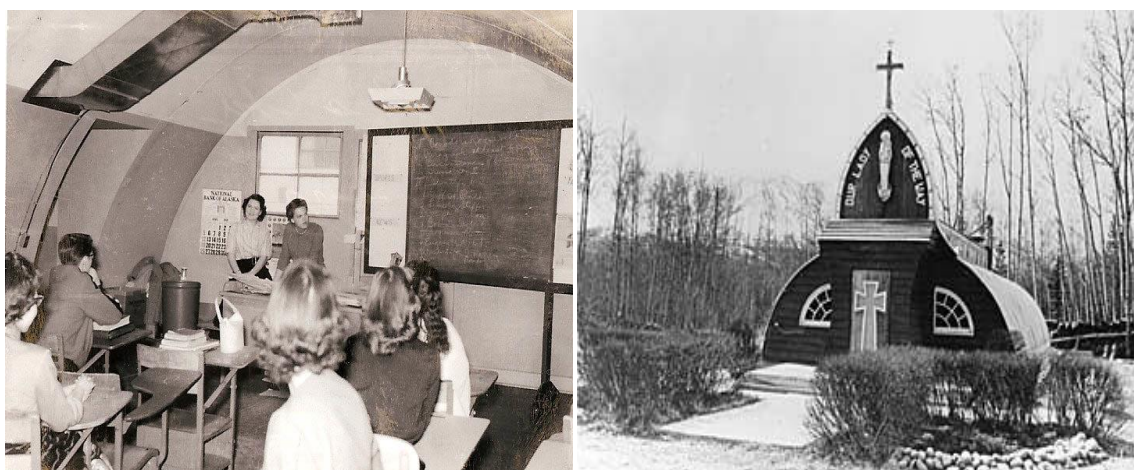
Figura 2.11: Abrigos Quonset utilizados como escola e igreja. EUA
