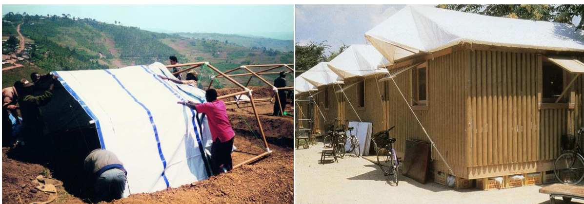
Figura 3.2: Abrigos temporários e transitórios em Ruanda e Kobe. 1995 Fonte: MCQUAID, 2003
