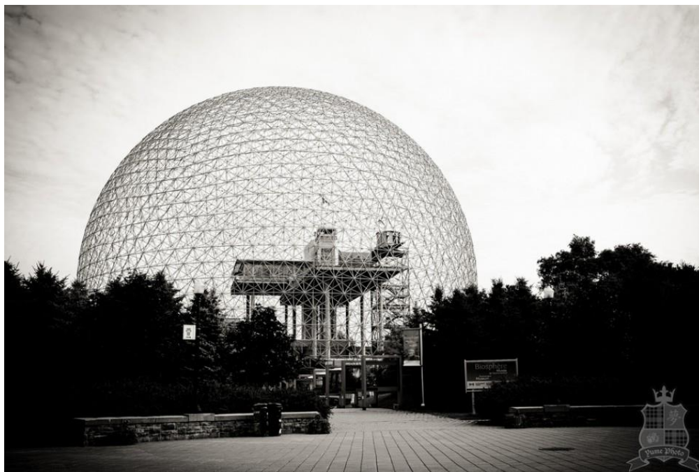
Figura 2.14: Pavilhão americano para a Expo de 1967 em Montreal. Fonte: ROUGIER, s.d
