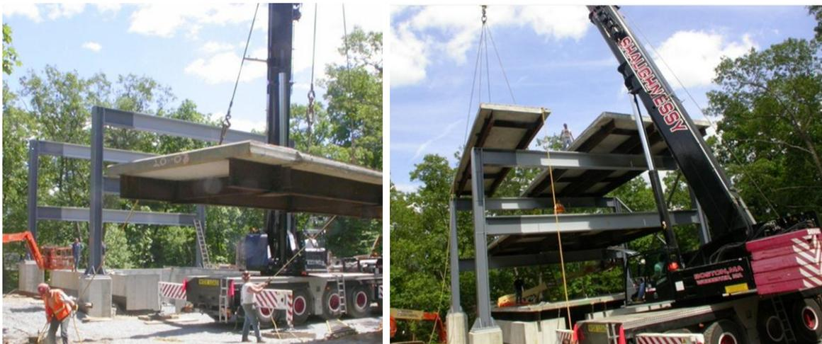
Figura 7.17: Imagens da construção da *Big Dig House*, com reuso de partes da ponte *Big Dig*.
