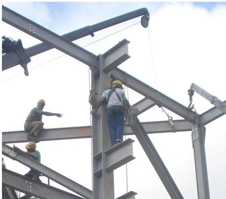
Figura D.1: Trabalhadores posicionados em pé sobre vigas para acesso temporário em construção metálica.
