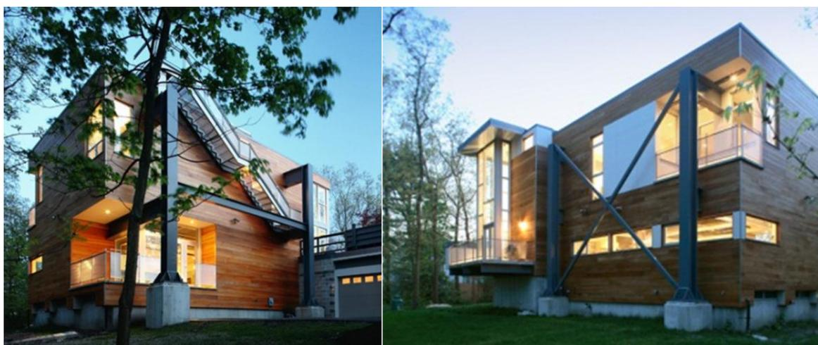
Figura 7.14: Imagem da *Big Dig House*, construída com aço da ponte BIG DIG.
