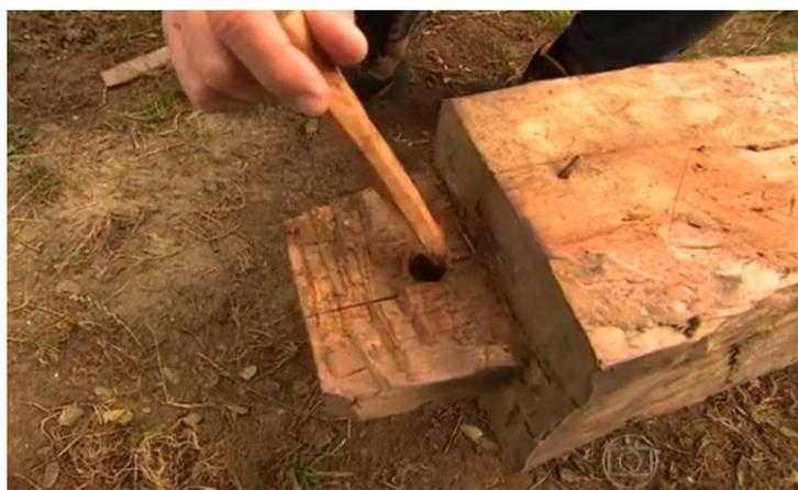
Figura 7.21: Sistema de encaixe dos templos em Chiloé: encaixe de tarugo em viga.
