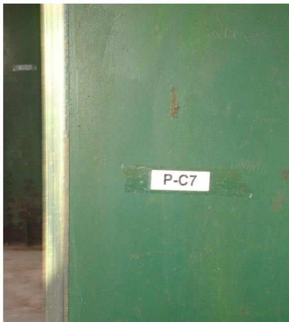
Figura G.25: Numeração dos pilares antes da desmontagem. Data: 04 de março de 2008.
