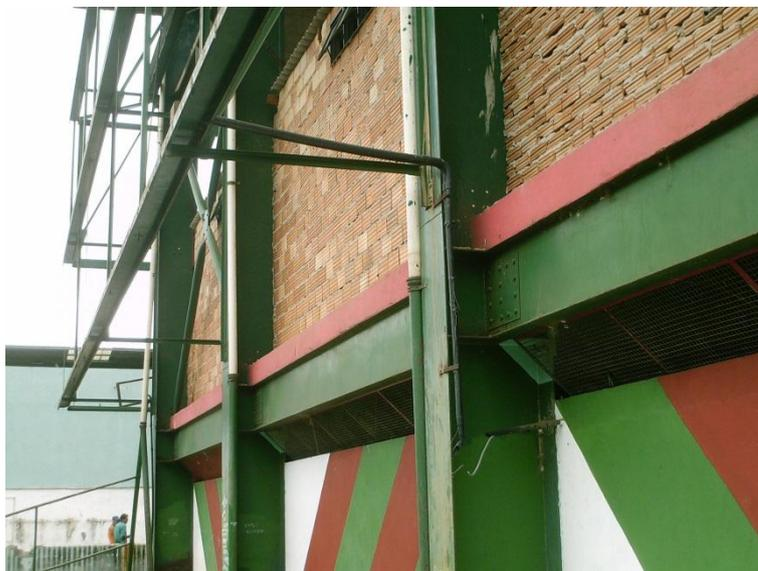
Figura G.9: Fechamento vertical em alvenaria do antigo Ginásio. Data: 24 de janeiro de 2008.
