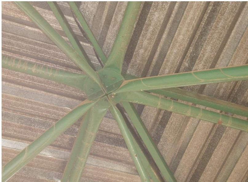
Figura G.22: Detalhe das ligações na estrutura de cobertura.
