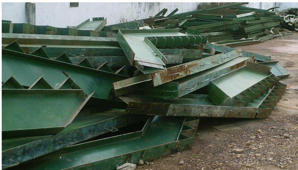
Figura G.20: Peças das arquibancadas retiradas sem danos. Data: 03 de junho de 2008.
