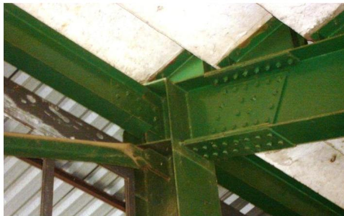
Figura G.18: Detalhe das ligações parafusadas da estrutura da arquibancada. Data: 24 de janeiro de 2008.
