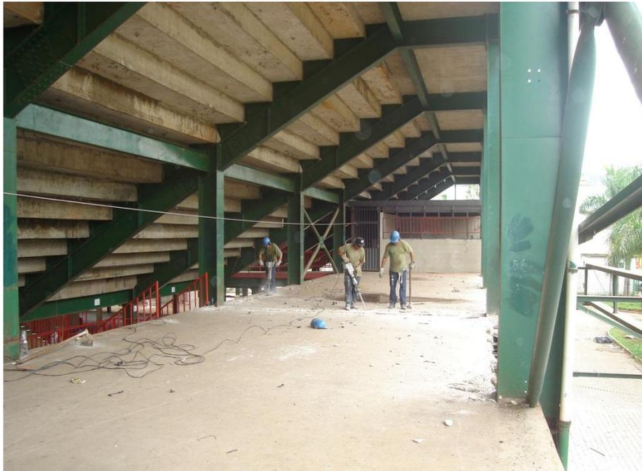
Figura G.5: Arquibancadas do antigo Ginásio vistas da parte inferior mostrando o apoio apenas nas extremidades. Data: 24 de janeiro de 2008.
