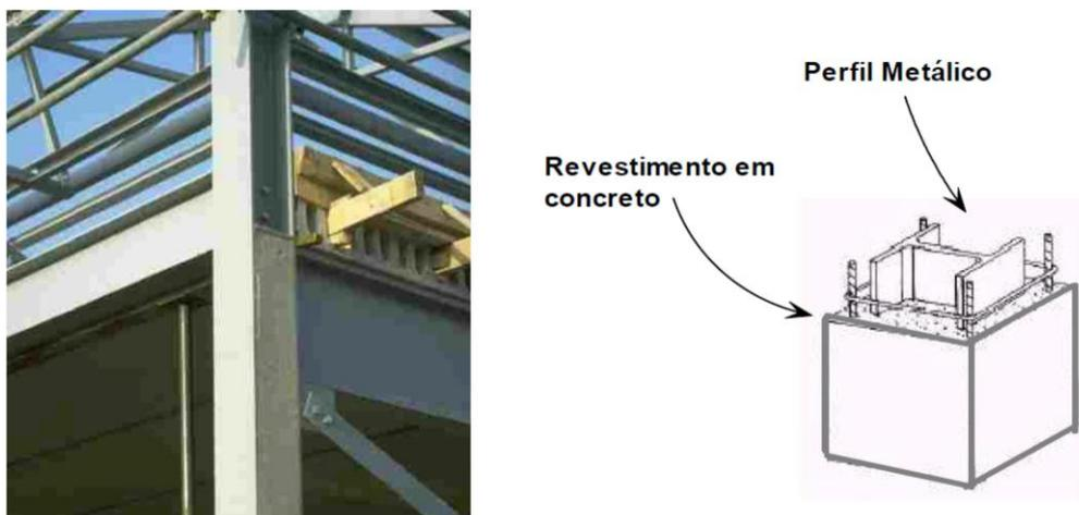
Figura 7.12: À esquerda pilar em aço enclausurado em concreto, à direita representação esquemática do pilar.
