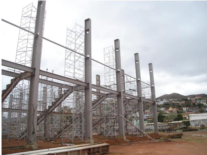
Figura G.24: Avanços na construção do novo Ginásio: fundações, pilares e vigas montados. Data: 31 de agosto de 2008. Fonte: RIBEIRO, 2008.
