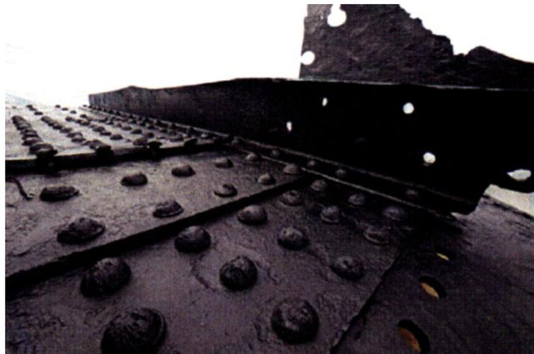
Figura B.3. Rebites, exemplo de conexão de sobrepor.
