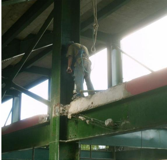
Figura G.10: Laje sendo separada de viga e pilar com o auxílio de uma britadeira. Data: 03 de junho de 2008.
