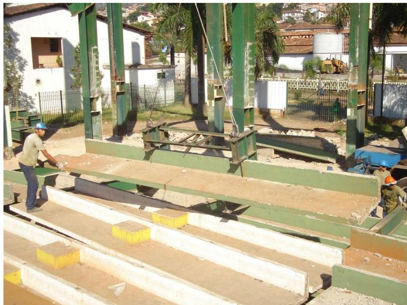
Figura G.4: Arquibancadas do antigo Ginásio sendo removidas. Data: 29 de abril de 2008.
