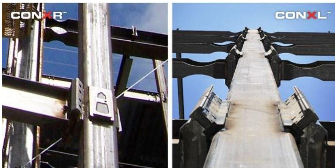
Figura B.10: (a) Detalhe da estrutura de ligação no pilar da ConX-R. (b) Detalhe da estrutura de ligação no pilar da ConX-L.
