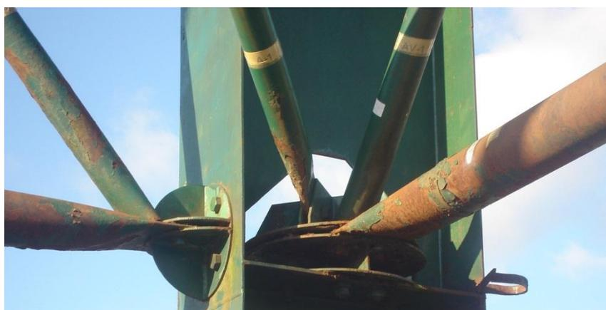
Figura G.26: Peças da cobertura etiquetadas antes da desconstrução.
