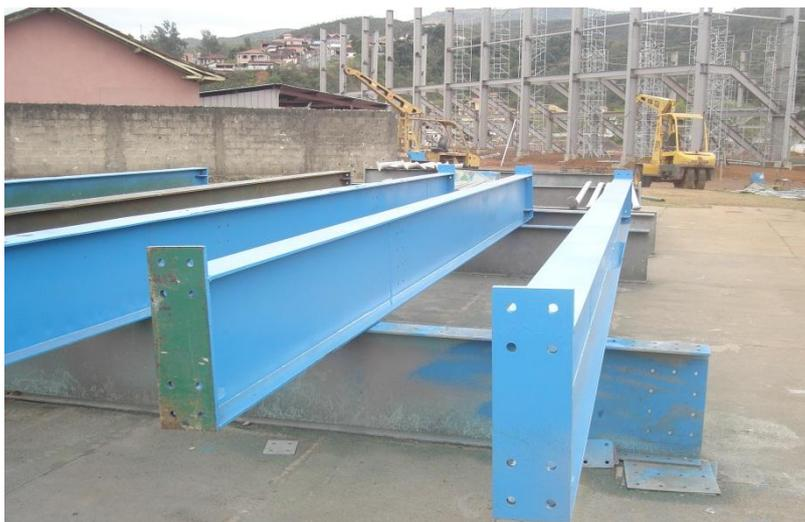
Figura G.23: Peças sendo restauradas e pintadas enquanto o novo Ginásio era construído aos fundos. Data: 31 de agosto de 2008.
