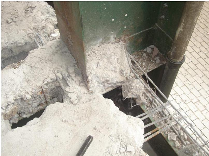
Figura G.11: Detalhe da separação entre laje e pilar. A interface entre o concreto e a estrutura dificultou o processo de desconstrução. Data: 24 de janeiro de 2008.
