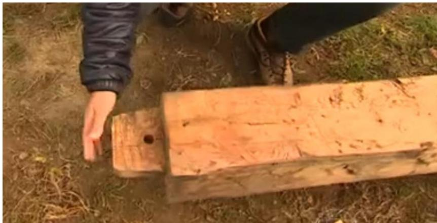
Figura 7.20: Sistema de encaixe dos templos em Chiloé: ponta de uma viga com um orifício.
