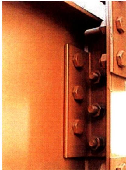
Figura B.4: Ligação parafusada, exemplo de conexão acessória do tipo interno.
