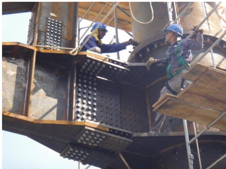
Figura B.5: Ligação parafusada complexa.
