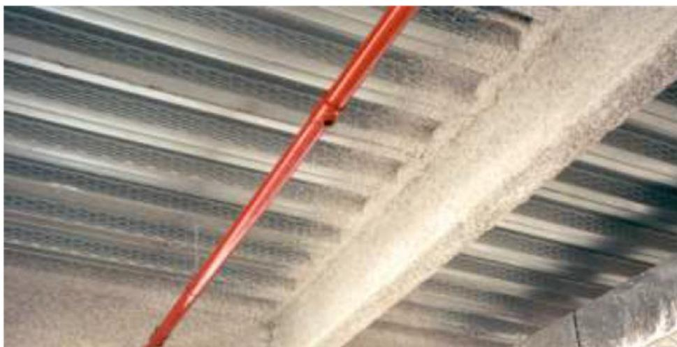
Figura 7.13: Argamassa projetada em vigas metálicas.
