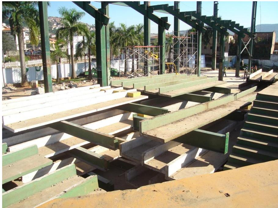
Figura G.6: Arquibancadas removidas e armazenadas de forma incorreta, com partes em balanço. Data: 29 de abril de 2008.
