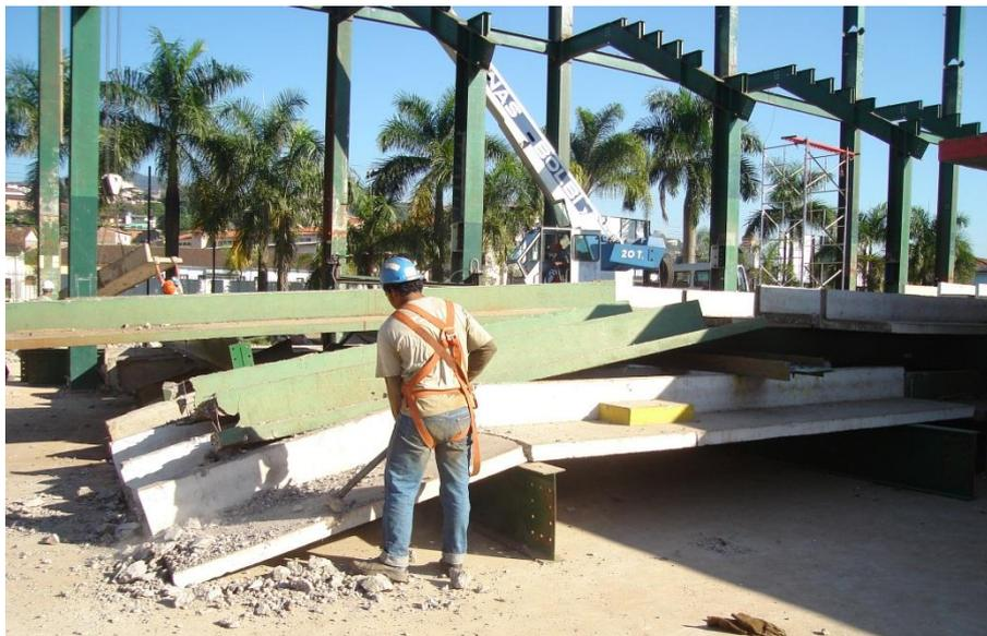
Figura G.7: Peças das arquibancadas danificadas devido ao armazenamento incorreto. Data: 29 de abril de 2008.
