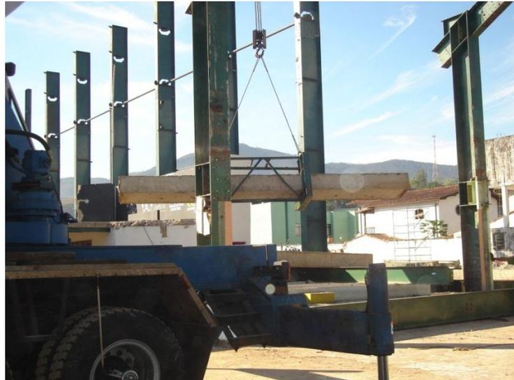
Figura G.3: Arquibancadas do antigo Ginásio sendo removidas. Data: 29 de abril de 2008.
