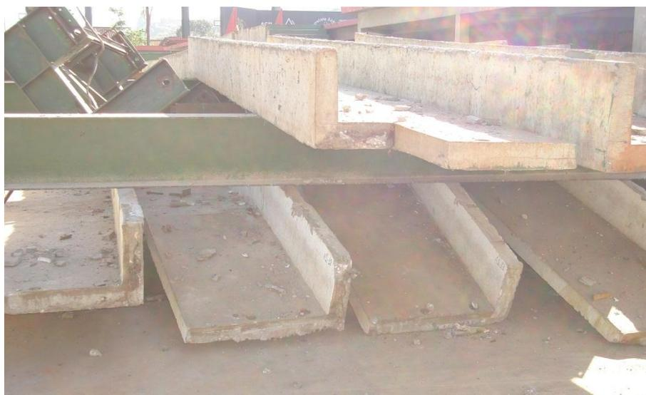
Figura G.8: Peças das arquibancadas danificadas devido ao armazenamento incorreto. Data: 29 de abril de 2008.
