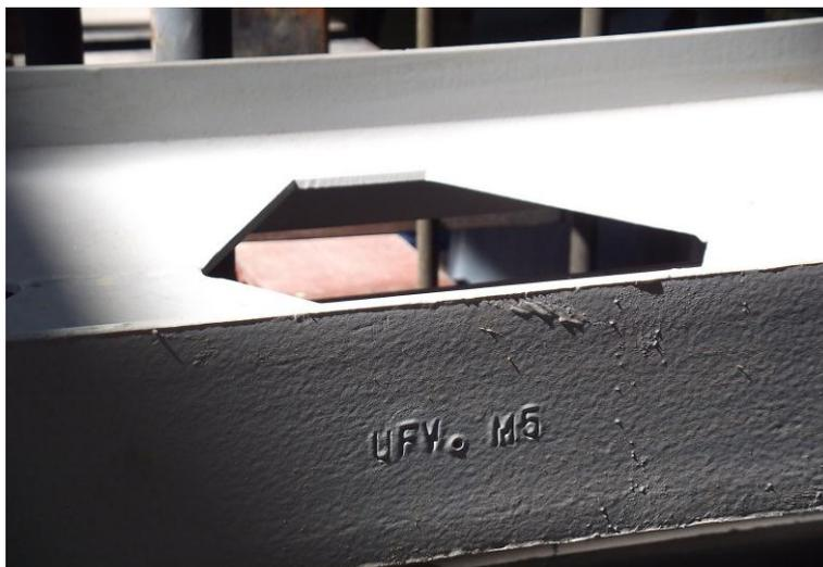
Figura 7.18: Sistema de identificação de estruturas de aço.
