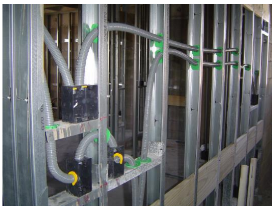
FIGURA 4.26 – Tubulação elétrica no Drywall.
