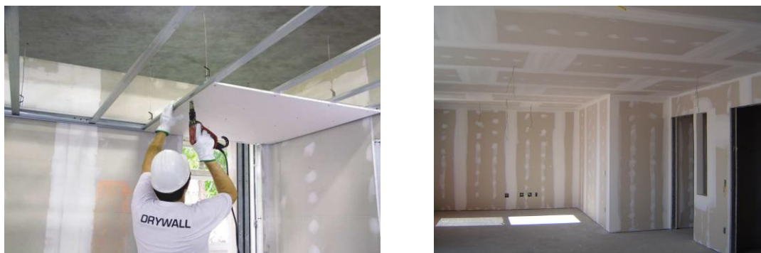
FIGURA 4.28 – Montagem forro, paredes de Drywall acabadas.
