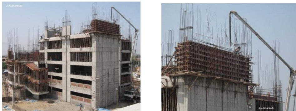
FIGURA 1.2 – Estrutura concreto armado
