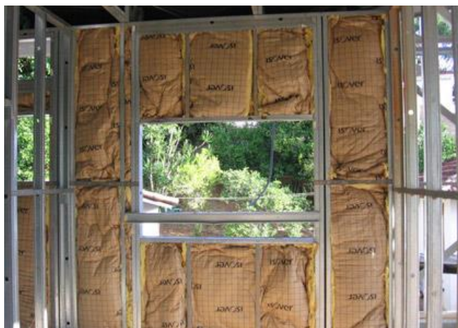
FIGURA 4.24 – Parede de Drywall interna preenchida com lã de poliéster.
