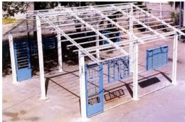
FIGURA 2.5 – Módulo estrutural do sistema Usiteto.
