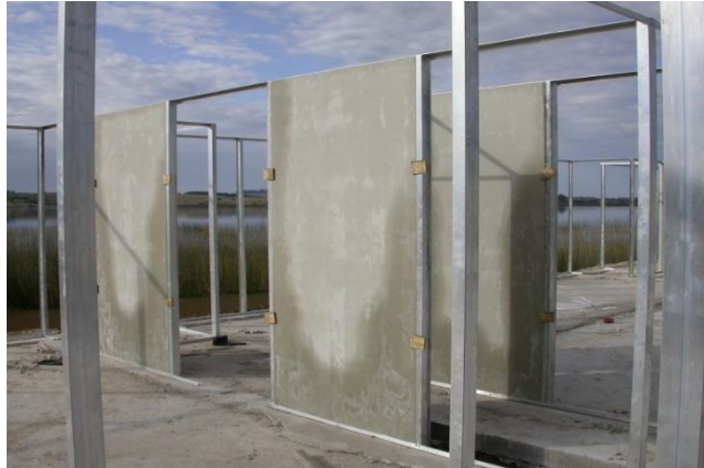
FIGURA 2.16 – Montagem dos painéis do sistema construtivo Nox.
