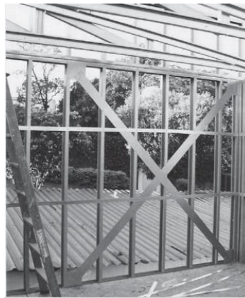
FIGURA 2.2 – Painel com contraventamento em X.
