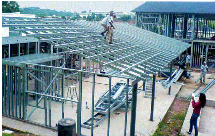
FIGURA 4.23 – Telhados com estrutura metálica galvanizada (LSF)
