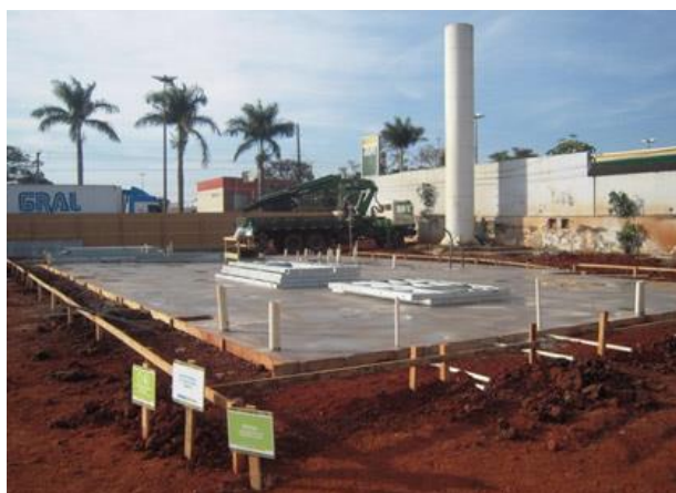
FIGURA 4.29 – Fundação tipo radier.
