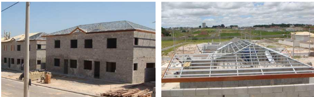
FIGURA 4.22 – Telhados com estrutura metálica galvanizada (LSF).
