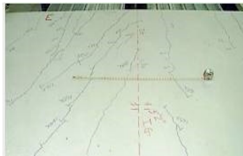
b) Fissuras paralelas às bielas de compressão
