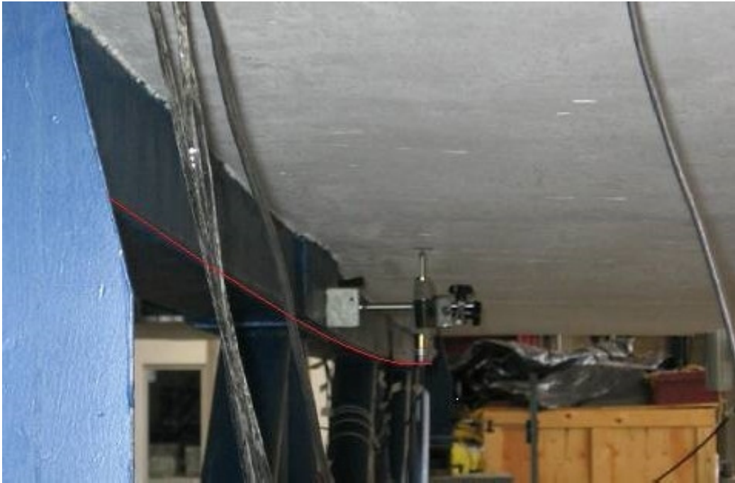
Figura 3.10 Imagem com a treliça mista deformada durante os ensaios
