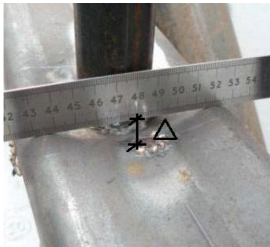
Figura 3.62 Medição do amassamento da parede banzo, adaptada de Nunes (2012)
