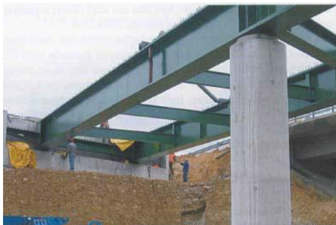
Fig. 5.36 – Sistema estrutural: bi-viga (Ferraz, 2009)
