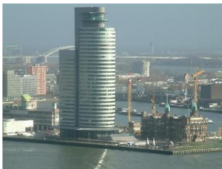
FIGURA 3.25 Torre World Port Center em Roterdã, Holanda Fonte: FOSTER, 2011.
