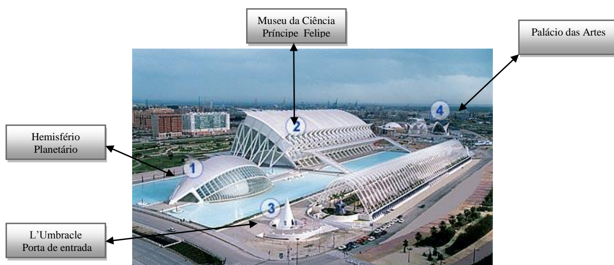
FIGURA 7. 4– Vista Geral da Cidade das Ciências e das Artes Fonte: Adaptado CIDADE DAS ARTES E CIENCIA, 2011.
