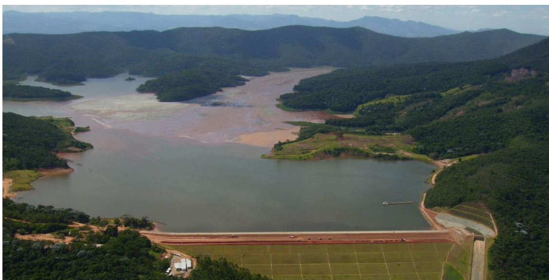
Figura 1.2- Barragem de contenção de rejeitos em Minas Gerais (FEAM, 2012).
