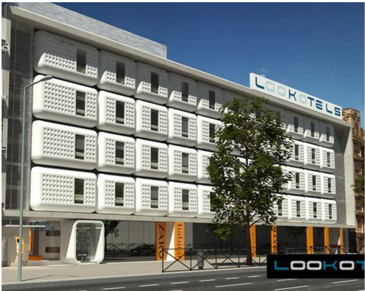
Figura 6.10 - Fachada do Lookotel composta pelos módulos tridimensionais.
