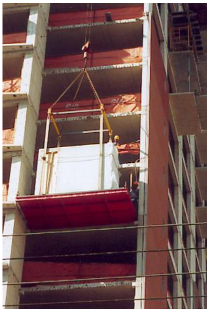
(c) módulos sendo içados para instalação na obra
