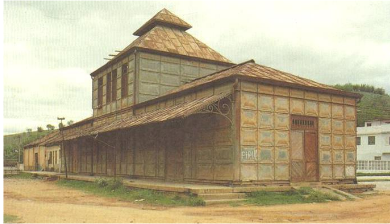
Figura 5.2 – Estação Ferroviária de Bananal (SP).
