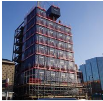
(a) processo de montagem
