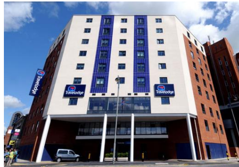
(c) obra concluída
